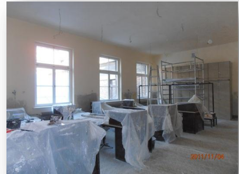
Centrum Kształcenia Praktycznego w Krakowie. Prace remontowe w pomieszczeniach warsztatowych placówki w 2011 roku.
