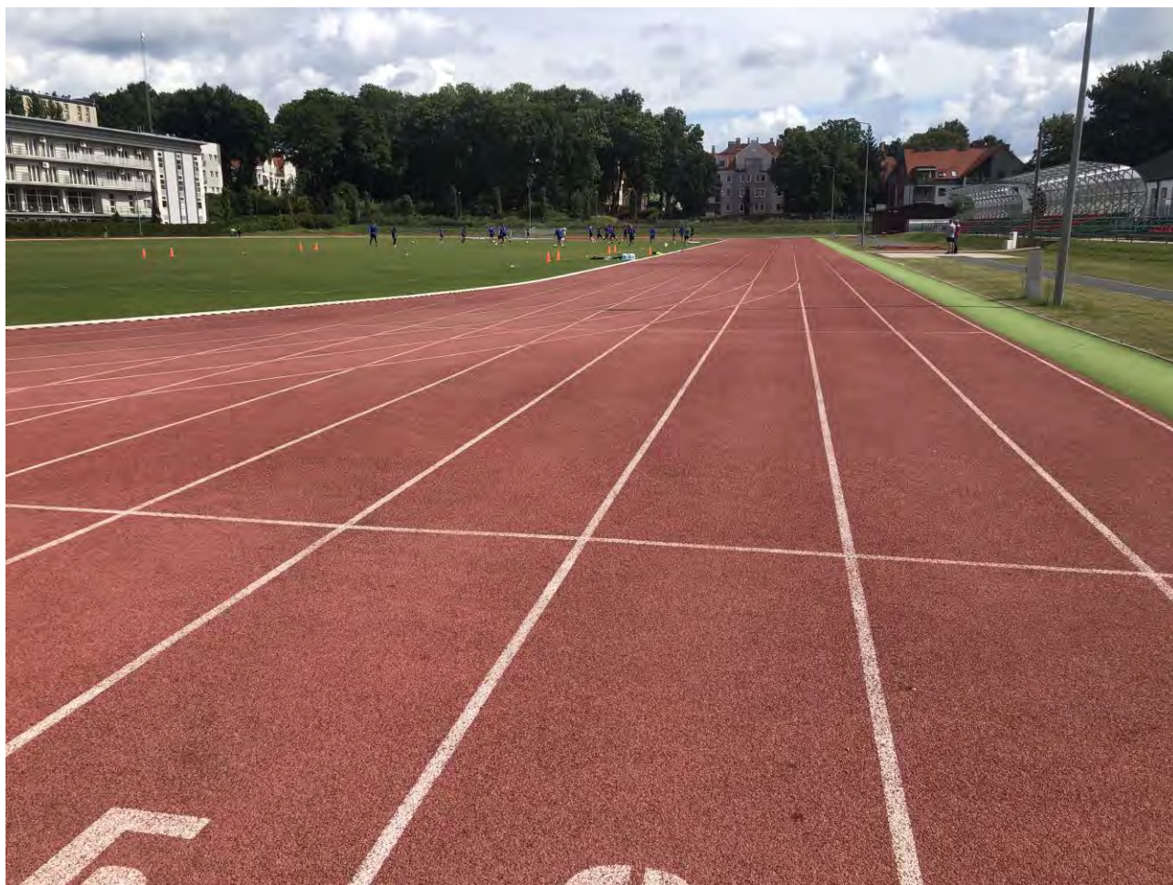
Fot. 1 Widok ogólny badanego obiektu – główna prosta
