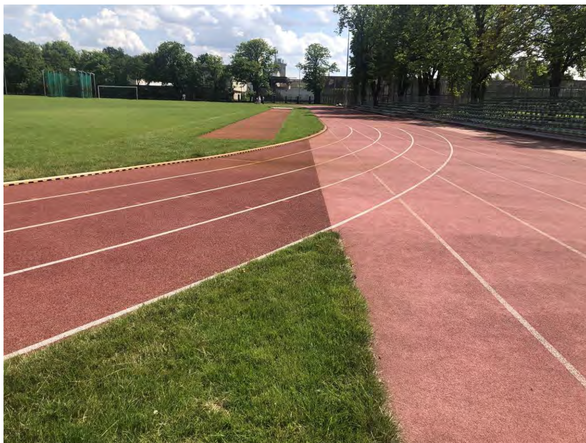
Fot. 3 Różnica w zabarwieniu zmodernizowanego łuku bieżni
