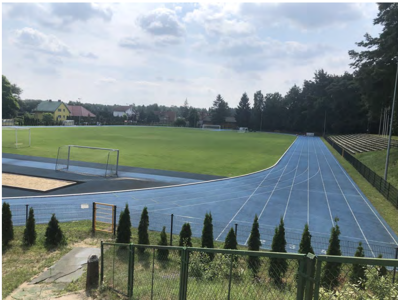
Fot. 1 Widok ogólny badanego obiektu – główna prosta
