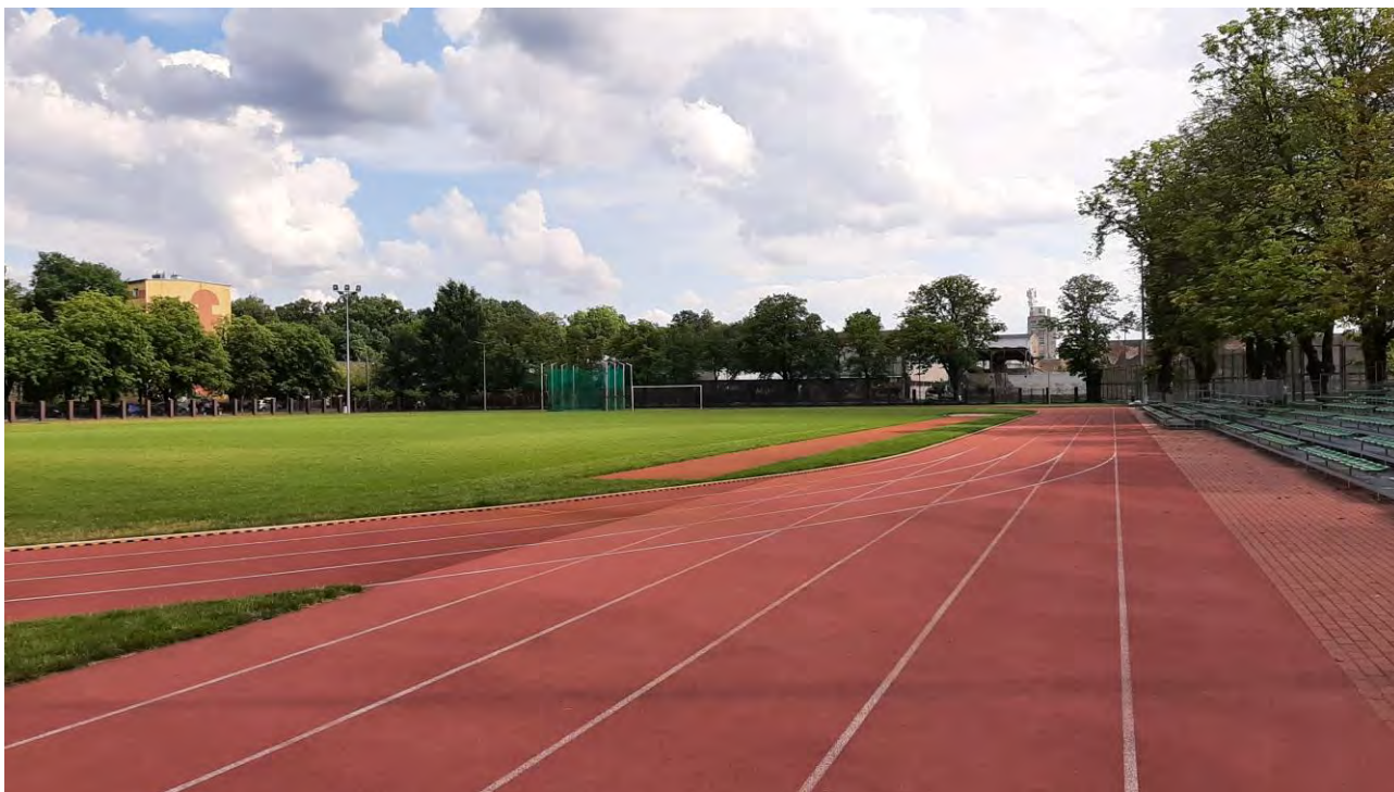
Fot. 1 Widok ogólny badanego obiektu – główna prosta
