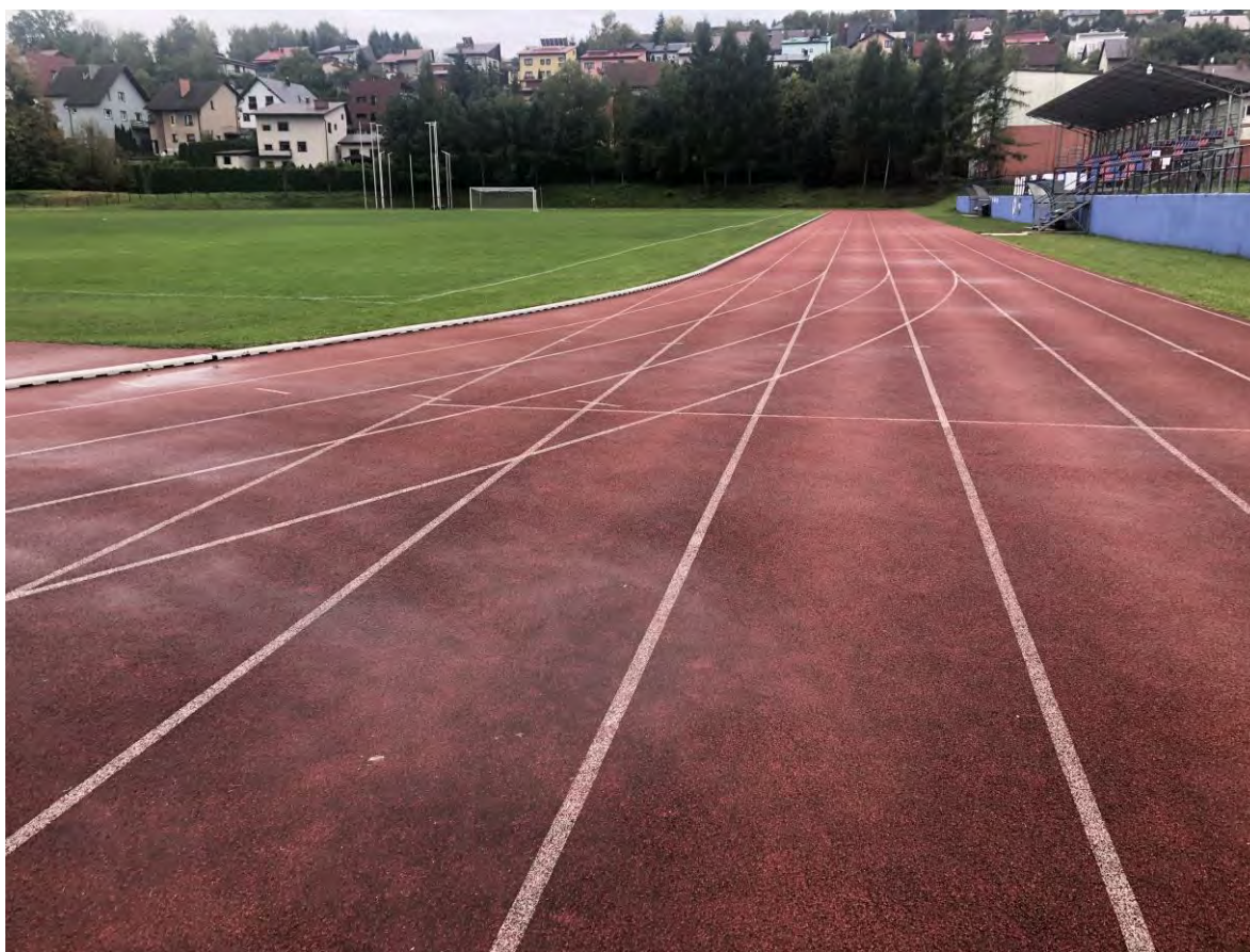
Fot. 4 Wytarcie warstwy użytkowej na torach biegowych.
