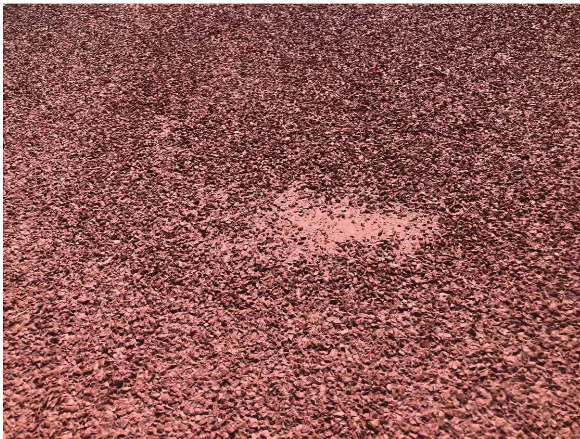
Fot. 5 Brak granulatu w warstwie użytkowej nawierzchni
