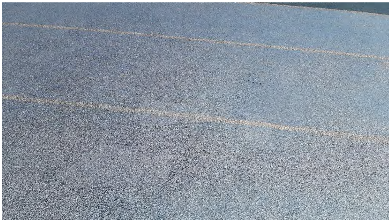
Fot. 3 Miejsca po naprawie nawierzchni
