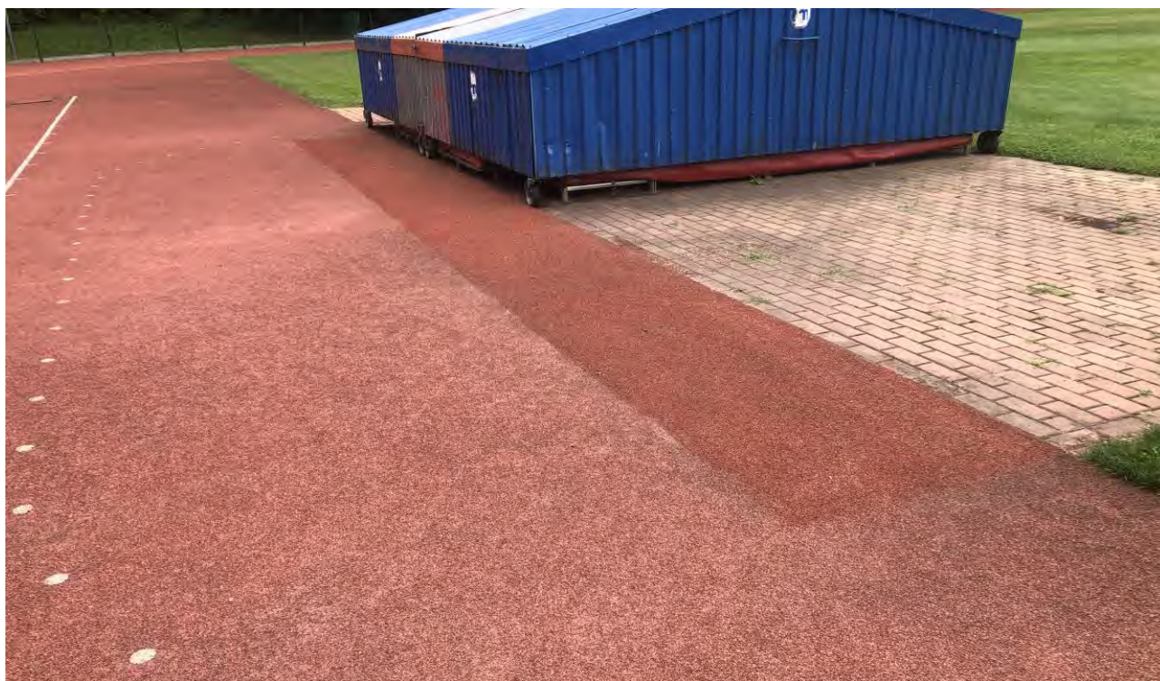
Fot. 6 Wstawiony nowy fragment nawierzchni na rozbiegu do skoku wzwyż
