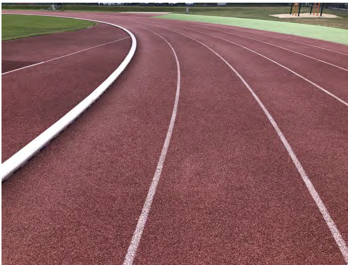
Fot. 9 Widoczne ślady wytarcia warstwy użytkowej nawierzchni na środkach torów
