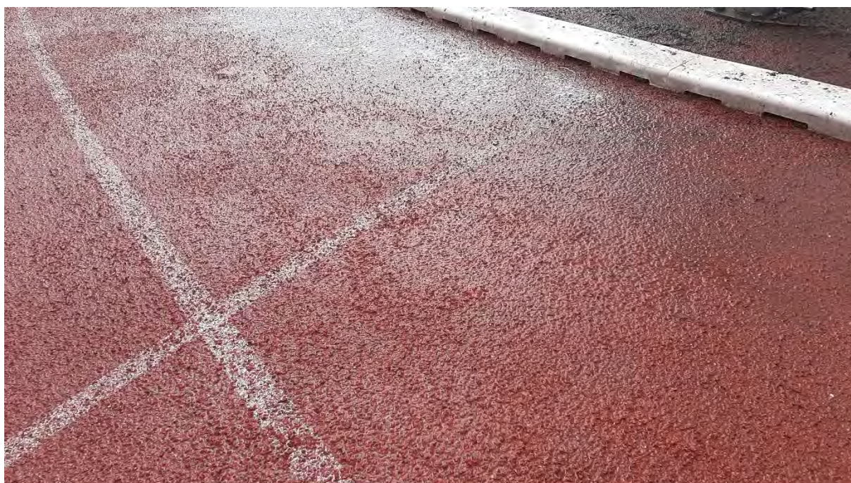
Fot. 18 Przykład nawierzchni z wydobywającym się z górnej warstwy granulatem EPDM
