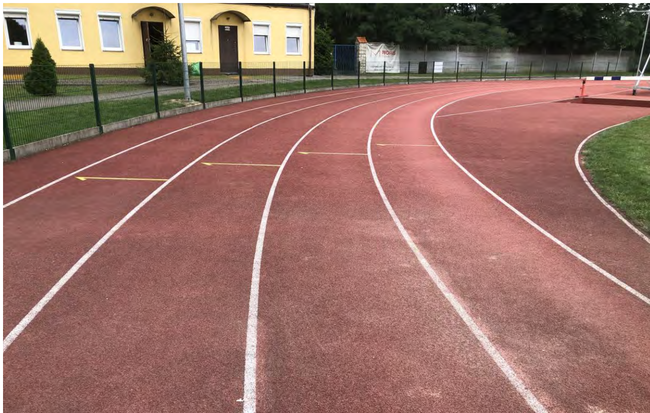
Fot. 8 Znaczne wytarcie warstwy użytkowej na torze pierwszym bieżni
