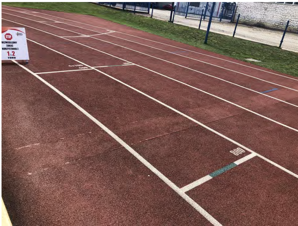
Fot. 7 Wstawiony fragment nawierzchni na całej szerokości bieżni
