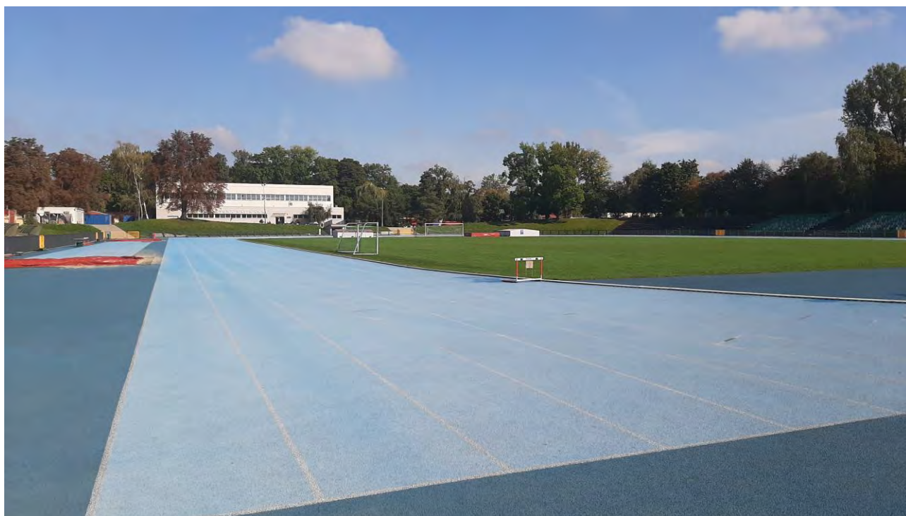
Fot. 4 Zauważalne wyblaknięcie koloru błękitnego
