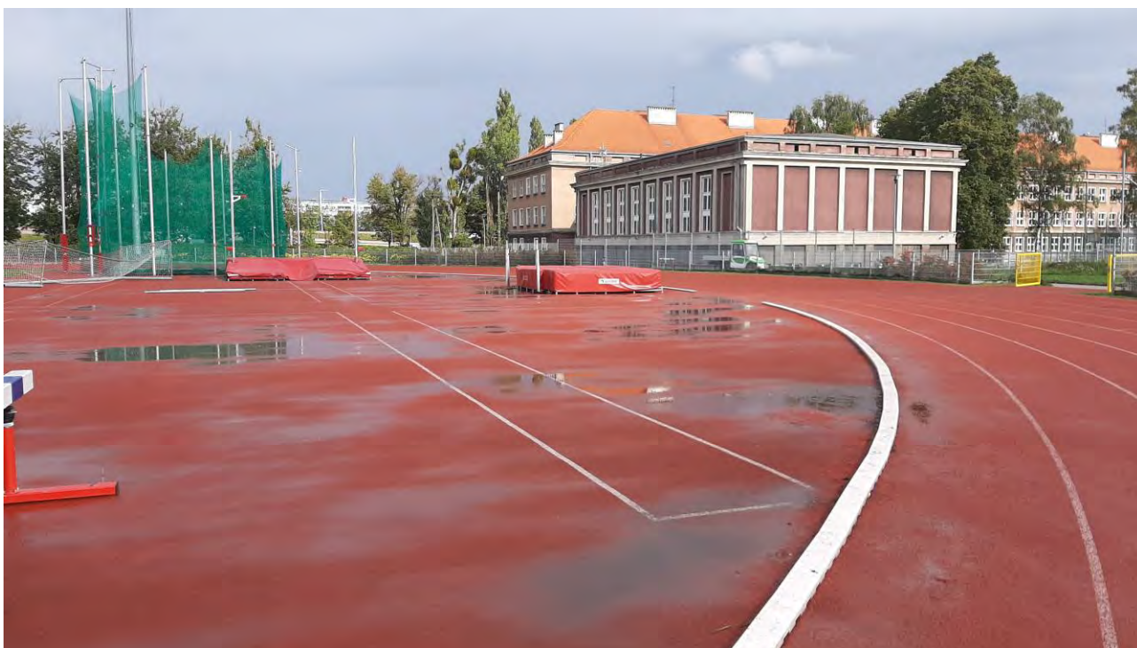
Fot. 6-10 Widoczne gromadzenie się granulatu na powierzchni oraz tworzące się zastoiny wodne
