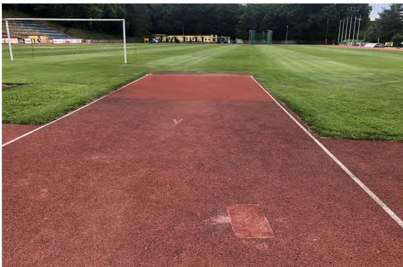
Fot. 7 Wstawiony nowy fragment nawierzchni na końcu rozbiegu do rzutu oszczepem
