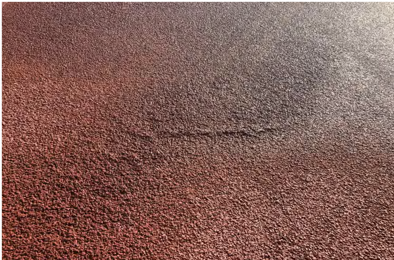
Fot. 4 Zgrubienie na warstwie użytkowej
