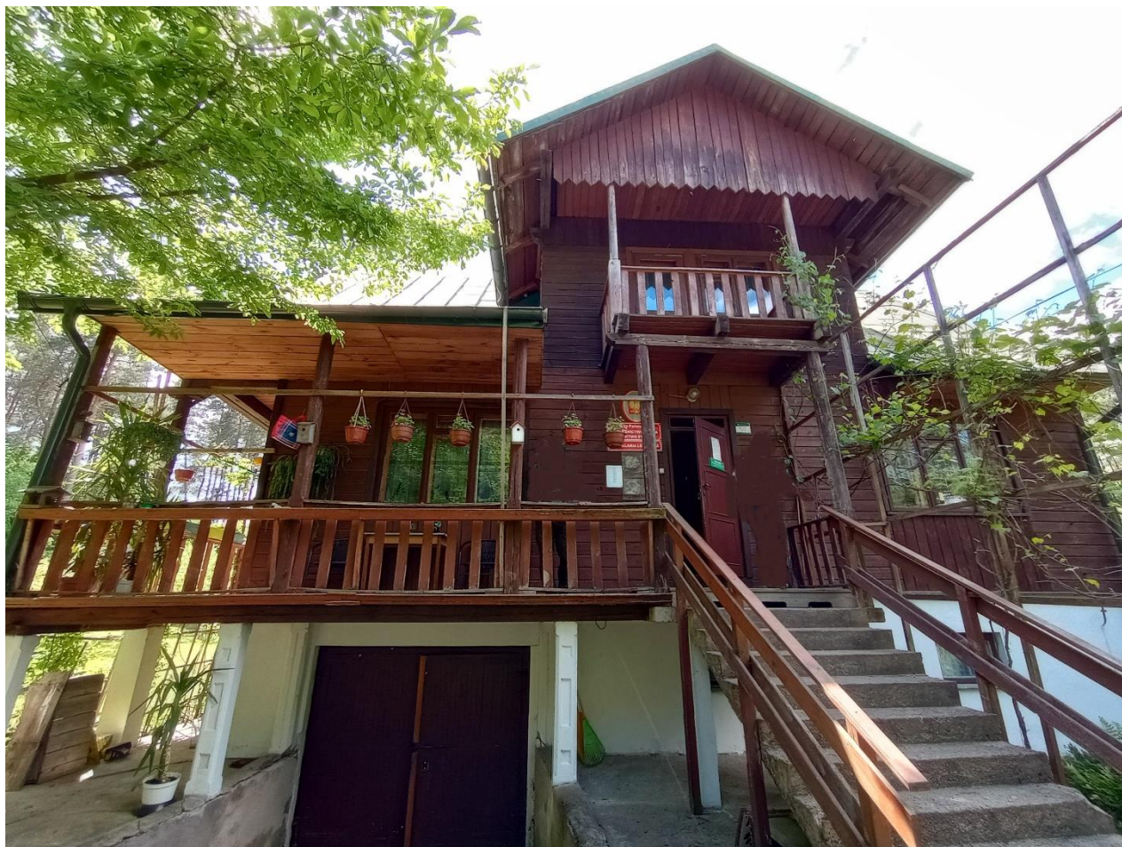
Fot. 1 Budynek mieszkalny – elewacja frontowa
