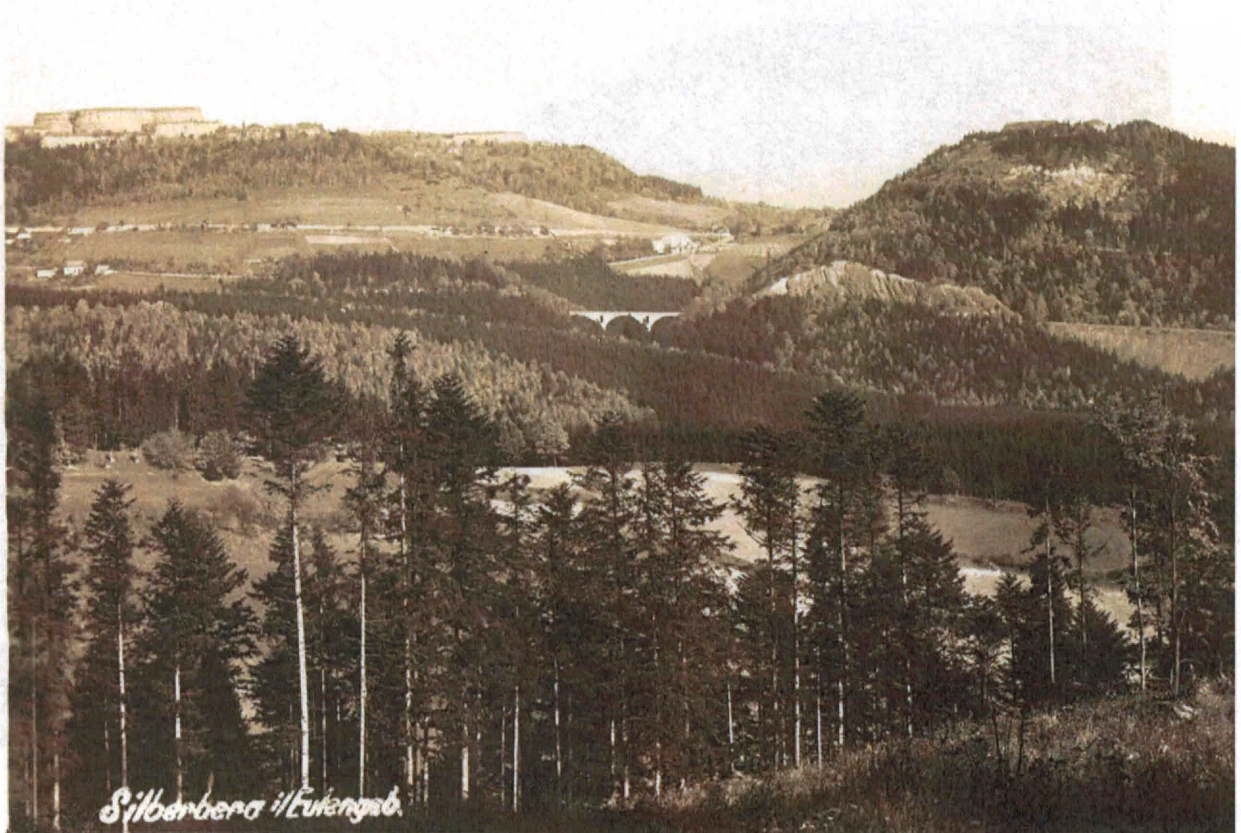
6. Widok z lat 20. XX w. na pierwszym planie Wiadukt Srebrnogórski, po prawej wyeksponowane skalne zbocze uformowane w trakcie przygotowania trasy kolei. W tle po lewej Donjon, po prawej Fort Ostróg.
