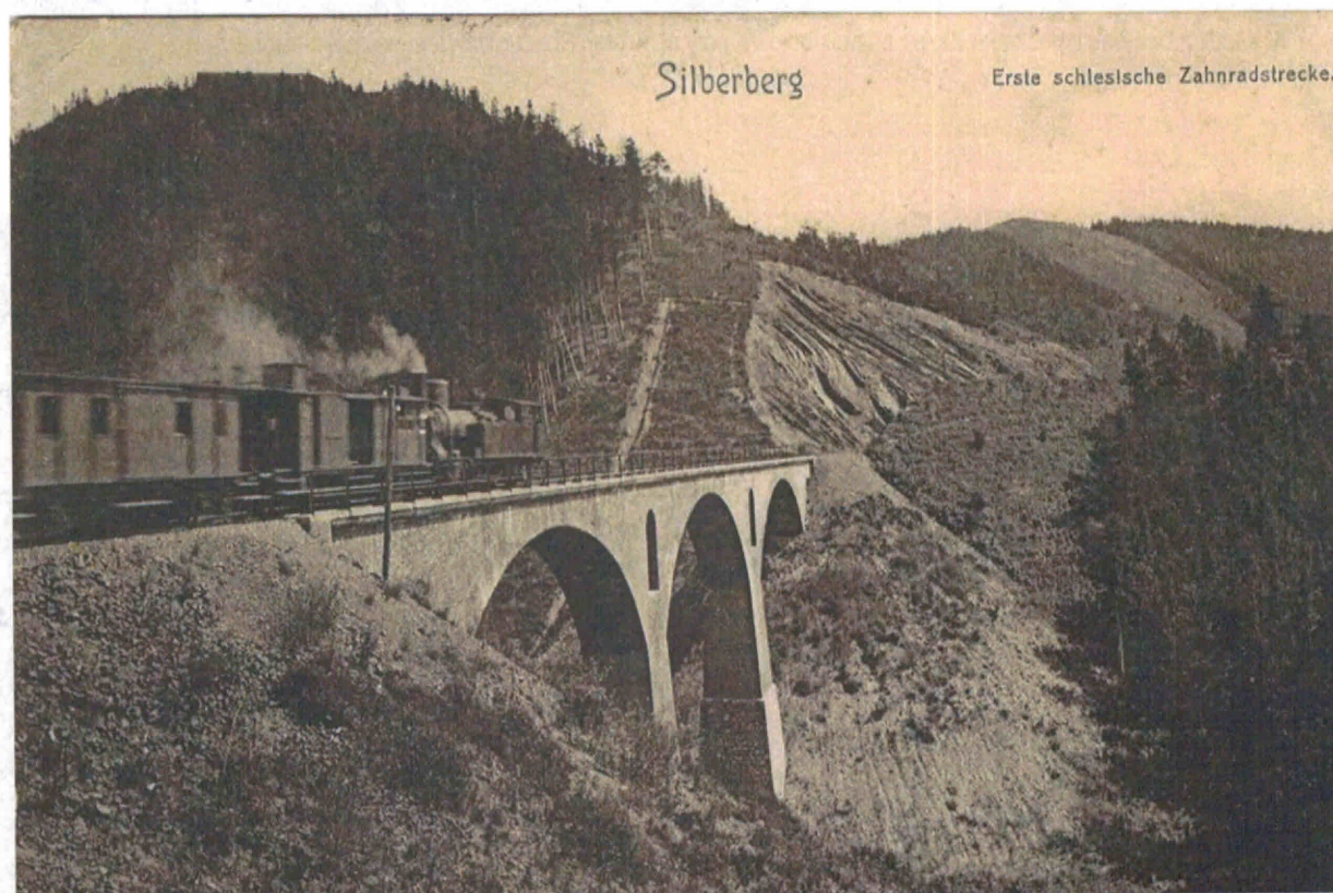
8. Widok z lat 20. XX w. na pierwszym planie Wiadukt Srebrnogórski z wyeksponowaną trasą kolei.
