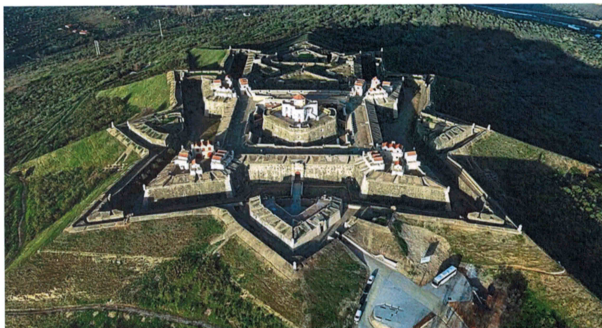
13. Fort da Graça w Portugalii, wpisany na listę światowego dziedzictwa UNESCO. Prawidłowy przykład ekspozycji celowo formowanych stoków bojowych stanowiących istotny element fortyfikacji.
