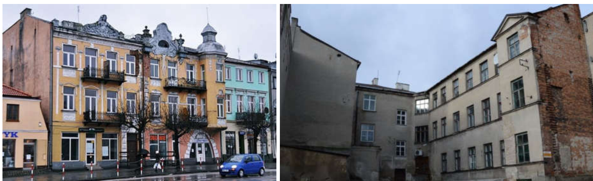
Rys. 5. Elewacje zabytkowej kamienicy - frontowa elewacja o bogatym detalu z koniecznością docieplenia wewnętrznego oraz elewacje boczne i tylne dla których należy rozważyć możliwość docieplenia od strony zewnętrznej
