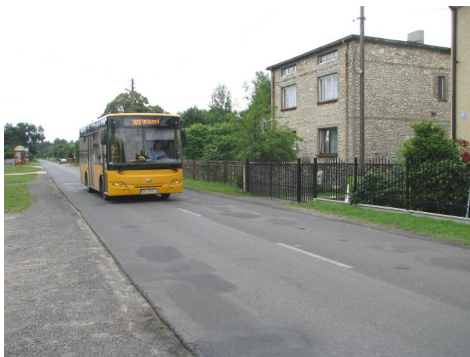
Fot. 11. Mierzęcice, RB4. Badany odcinek ul. Kolejowej w kierunku skrzyżowania z ul. Wspólną
