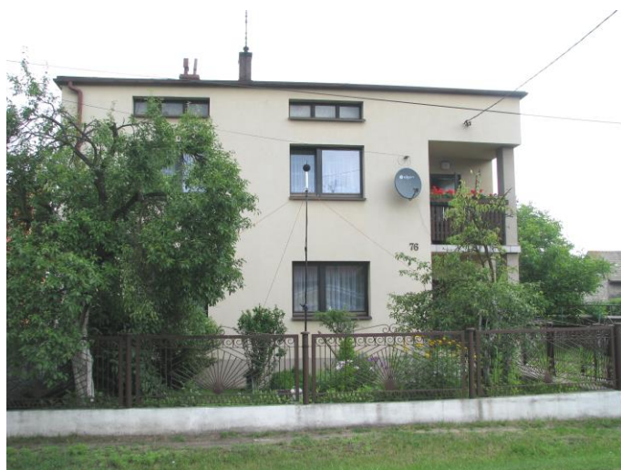
Fot. 9. Mierzęcice, RB4. Lokalizacja punktu pomiarowego przy ul. Kolejowej
