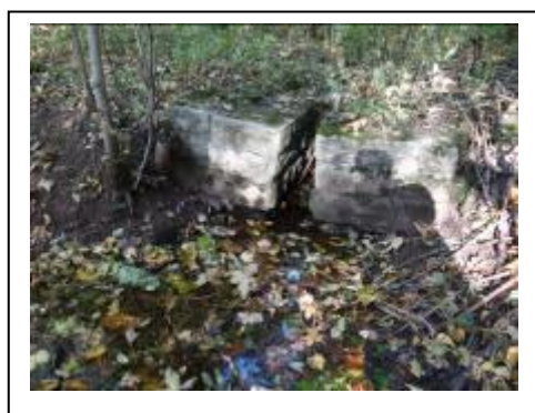
t. przepust kamienny otwarty km 7,330 – częściowo zniszczony i zawalony
