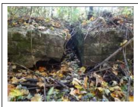
t. przepust kamienny otwarty km 7,330 – częściowo zniszczony i zawalony
