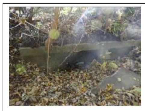
v. przepust kamienny płytowy km 7,702
