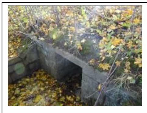
t. przepust kamienny otwarty km 7,330 – częściowo zniszczony i zawalony
