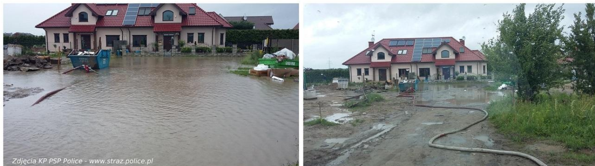
Rys. 23 i 24. Usuwanie skutków podstopeń na terenie gminy Dobra.
