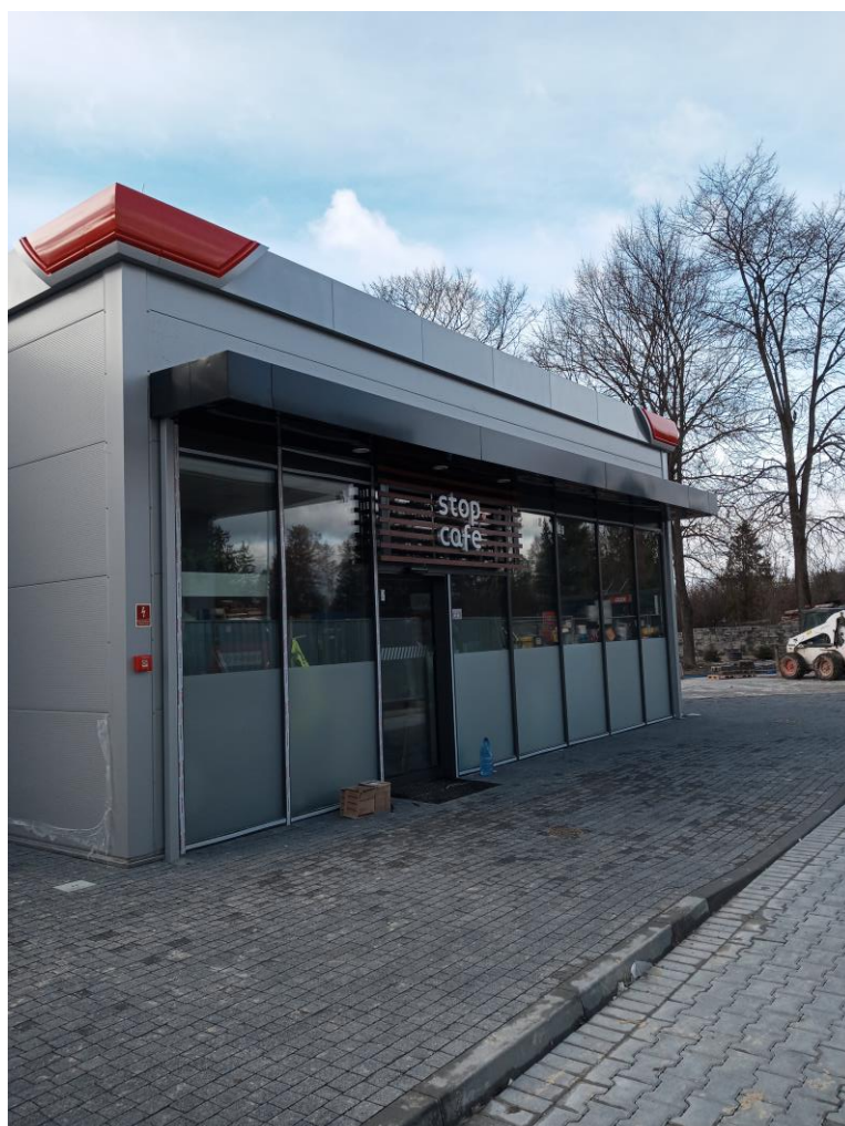
Budynek stacji paliw
