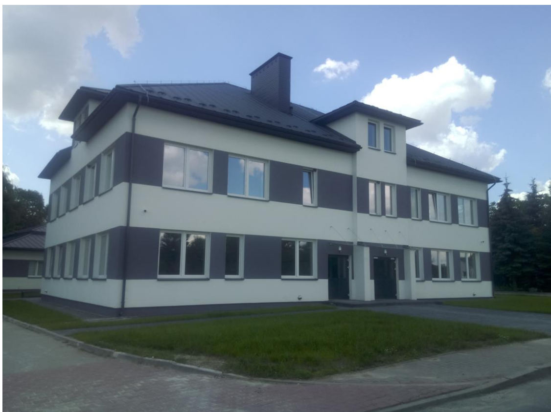
Budynek gminnego przedszkola
