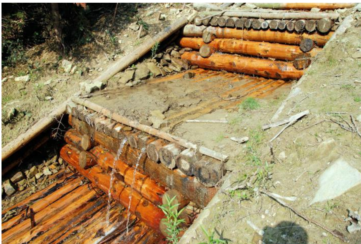
Zabudowa potoku – progi (fot. J. Zygarowicz)
