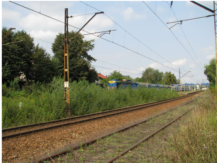
Fot. 3. Czechowice-Dziedzice, linia kolejowa nr 139 w kierunku Katowic.
