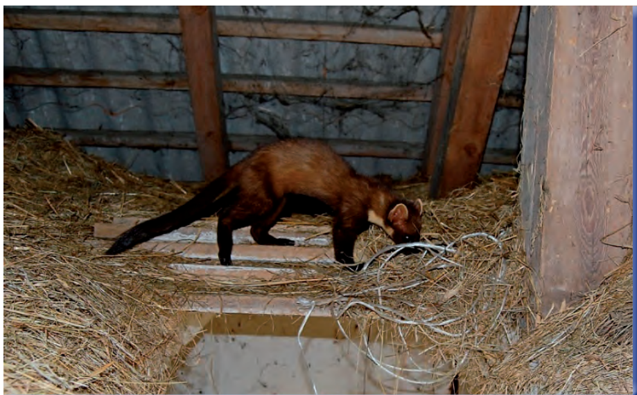
Zdarza się, że kuny zamieszkują na poddaszu domu i czynią szkody, drżąc korytarze w wełnie mineralnej lub przegryzając kable instalacji elektrycznej (fot. Jacek Więckowski)
