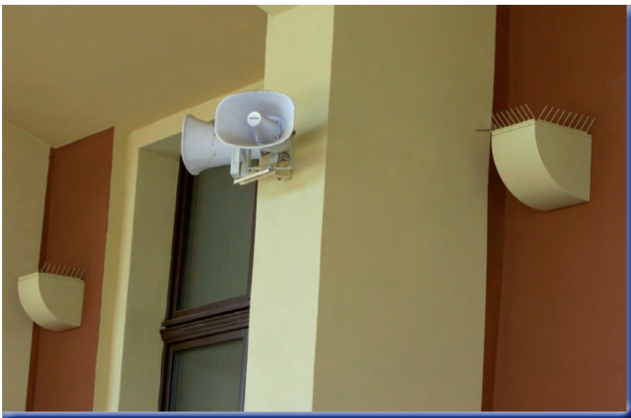
Przykład gzymsów zabezpieczonych kolcami przed ptakami (fot. Stanisław Bąkowski)
