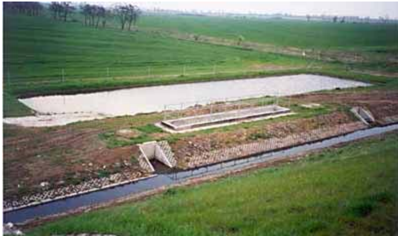
Fot. 5.3. Zbiornik infiltracyjny
