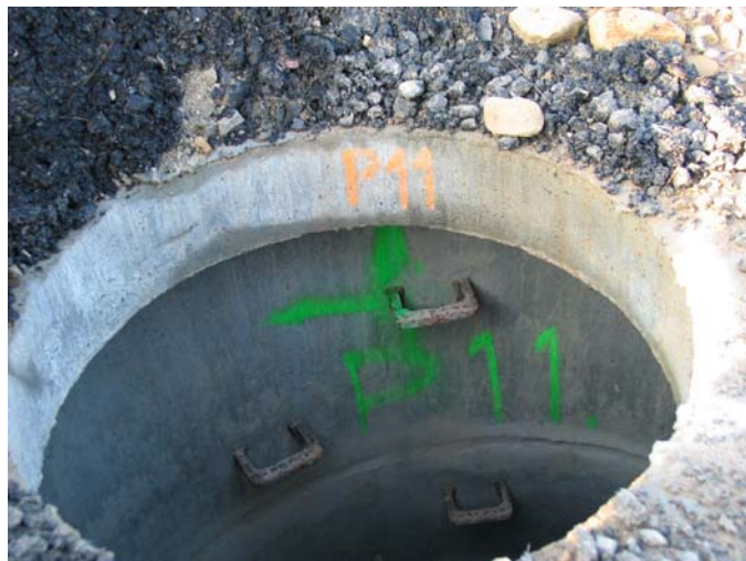
Fot. 9.2. Punkty w studniach kanalizacji deszczowej
