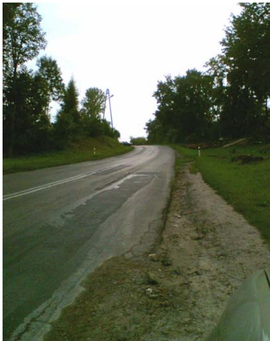
Fot. 11.3. Wymywanie kruszywa z pobocza
