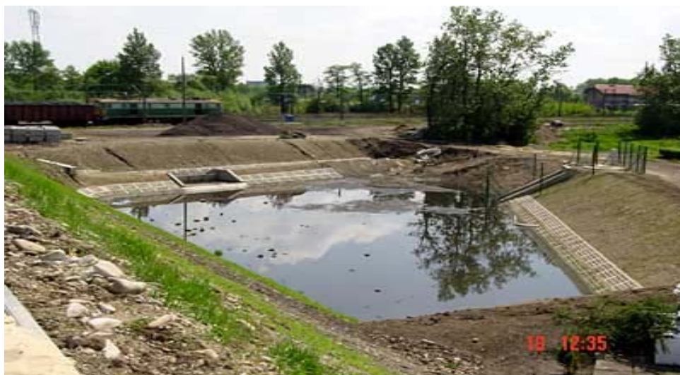
Fot. 5.4. Zbiornik retencyjno - filtracyjny
