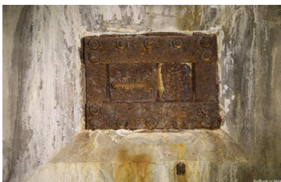
Fotografia 17 Kompletna strzelnica obrony wewnętrznej w schronie bojowym Ru.10, leśnictwo Złotowo, oddział 282
