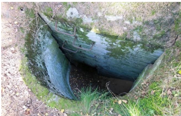
Fotografia 19 Studzienka wyjścia ewakuacyjnego w schronie Ru.17/18, leśnictwo Złotowo, oddział 280
