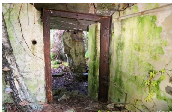
Fotografia 18 Stalowa ościeżnica w bojowym schronie dwusektorowym Zie.7/8, leśnictwo Krępa, oddział 299
