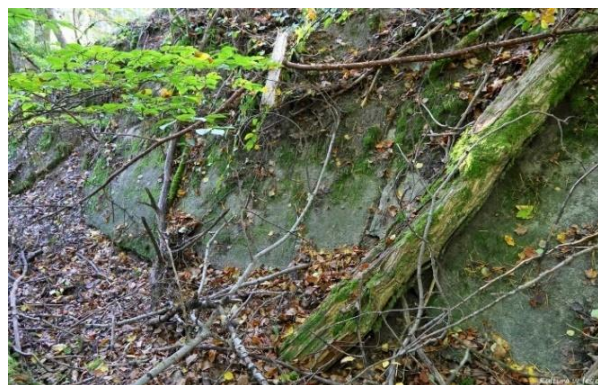
Fotografia 23 Fragment wyłożonego betonowymi płytami rowu przeciwczołgowego na odcinku taktycznym Gr.Ga, leśnictwo Złotowo, oddział 280
