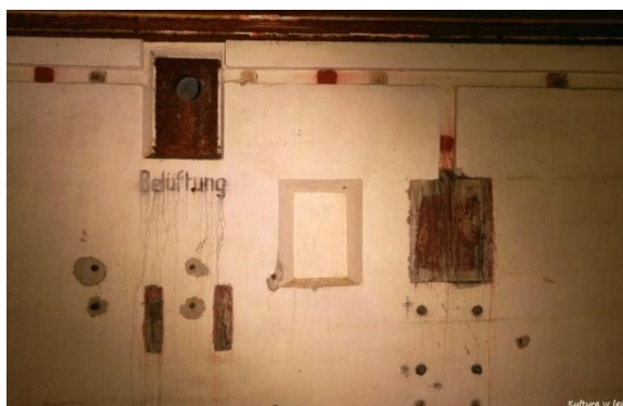
Fotografia 16 Ściana izby pogotowia schronu bojowego Gall.8: wylot przewodu wentylacyjnego, nisza na oświetlenie, miejsce na telefon, korytka na przewody telefoniczne. Leśnictwo Rutwica, oddział 255
