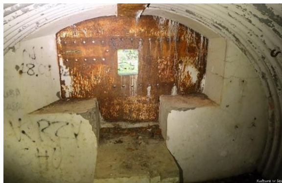
Fotografia 8 Wnętrze schronu bojowego Pr.Ost.9 z zachowaną płytą pancerną
