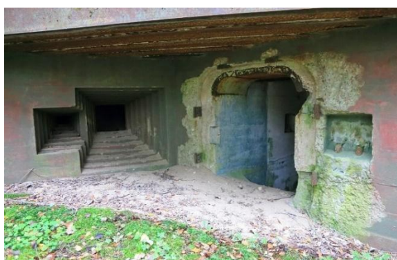
Fotografia 10 Elewacja wejściowa schronu dowodzenia Kle.A.B., leśnictwo Strzaliny, oddział 411
