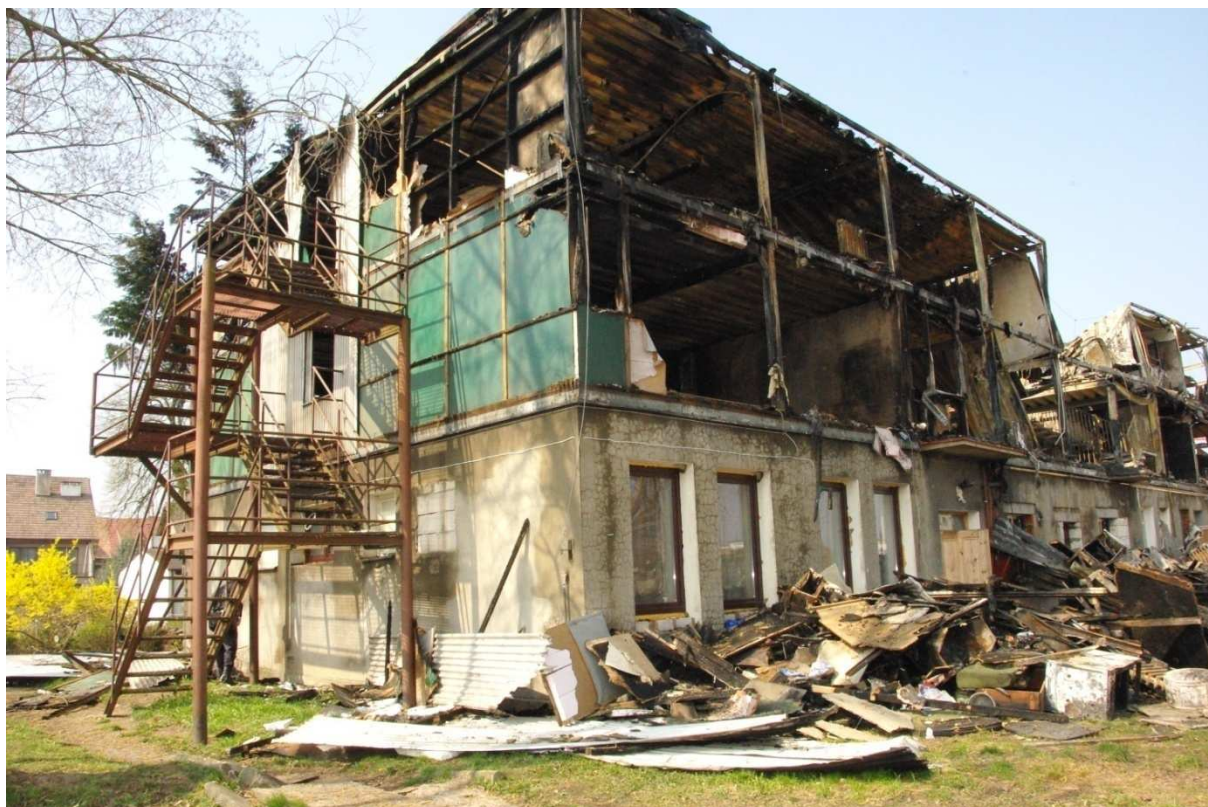
Fot. 6. Widok budynku od strony południowo-wschodniej. Źródło: KMP Kamień Pomorski.
