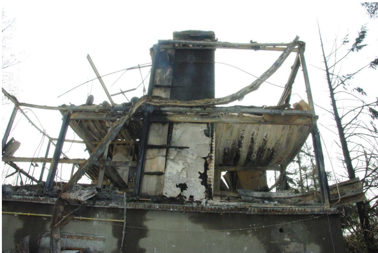
Fot. 3. Widok budynku od strony północnej.
