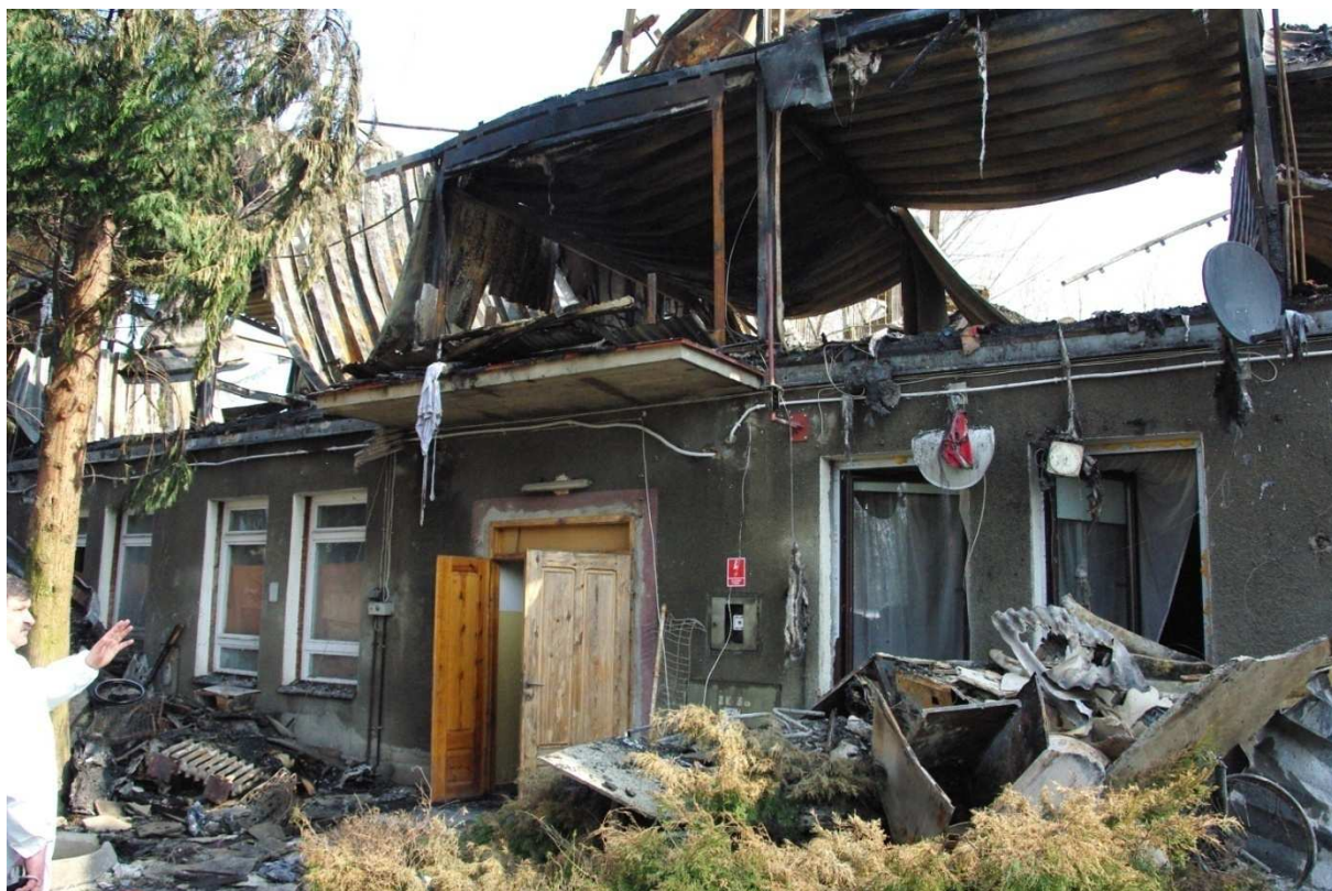
Fot. 2. Widok budynku od strony zachodniej (od ul. Wolińskiej). Źródło: KMP Kamień Pomorski.
