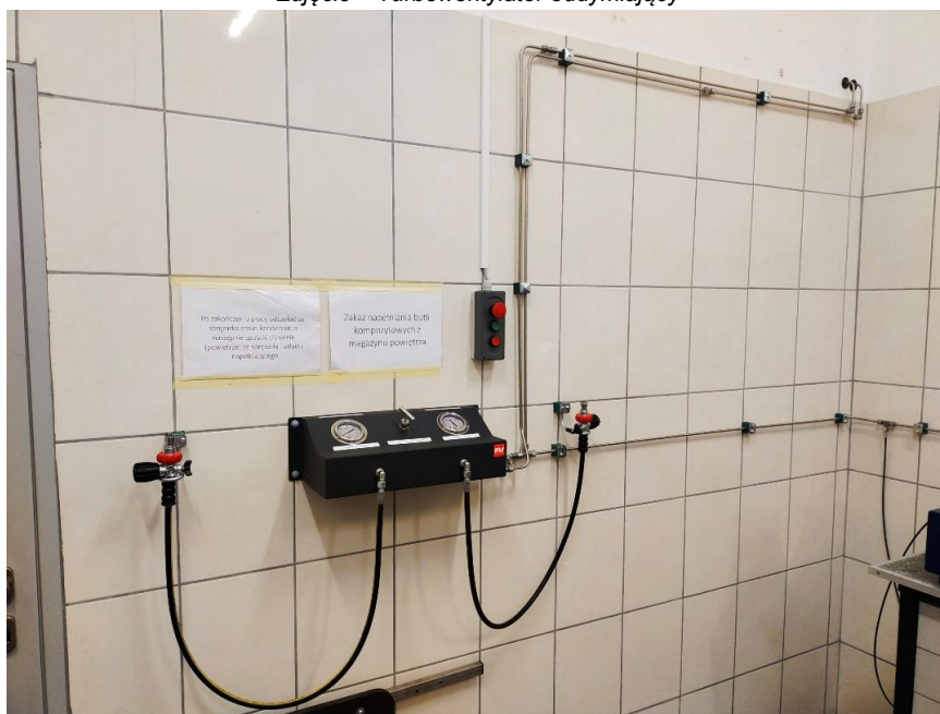
Zdjęcie - panel napełniający do butli OOU
