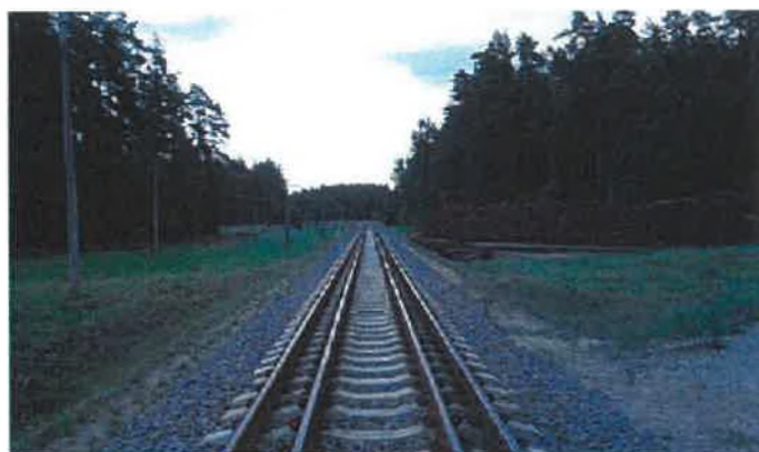
Splot torowy na Litwie. Różnica szerokości między prześwitem „europejskim” a „radzieckim” jest zbyt mała, by można było stosować tor trójszynowy, dlatego też zastosowano splot czteroszynowy – pociągi 1435 mm korzystają z szyn 2 i 4, pociągi 1520 mm – z 1 i 3.
