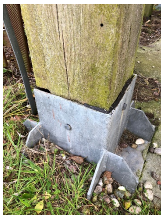
Korozja biologiczna głównych elementów konstrukcji wieży
