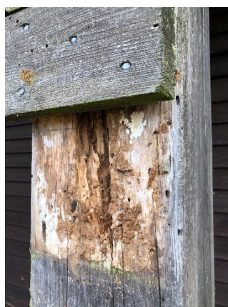
Korozja biologiczna głównych elementów konstrukcji wieży
