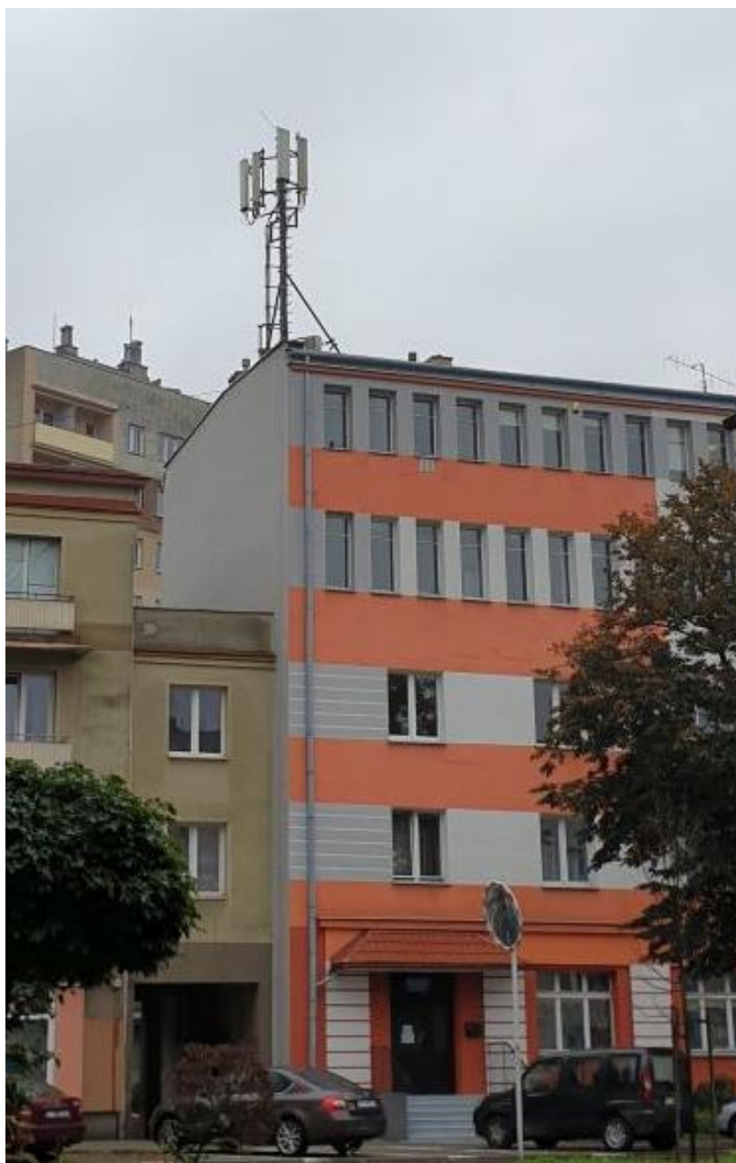
Fot. 1: Widok anten stacji bazowej: ID: 58187 (20187), zlokalizowanej pod adresem: ul. Hetmańska 15, 35-045 Rzeszów
