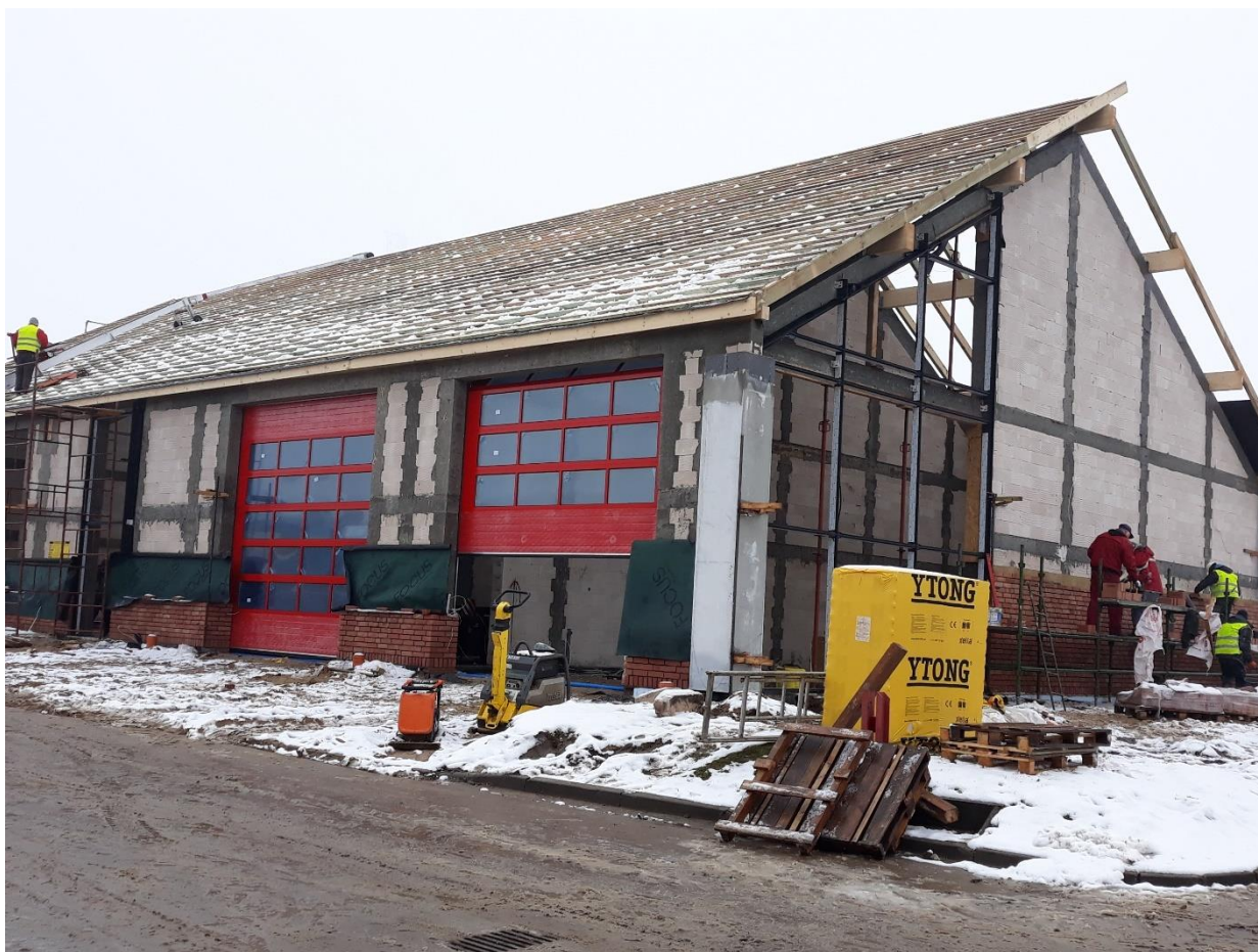
Zdjęcie: Budowa budynku zaplecza techniczno-magazynowego dla KP PSP w Bartoszycach.
