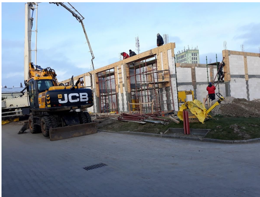
Zdjęcia: Budowa budynku zaplecza techniczno-magazynowego dla KP PSP w Bartoszycach.
