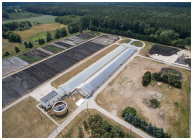
Oczyszczalnia ścieków Iławskich Wodociągów to obiekt samowystarczalny: w 100% pod względem energii cieplnej i w ok. 98% w zakresie energii elektrycznej (fot. Iławskie Wodociągi Sp. z o.o.)
