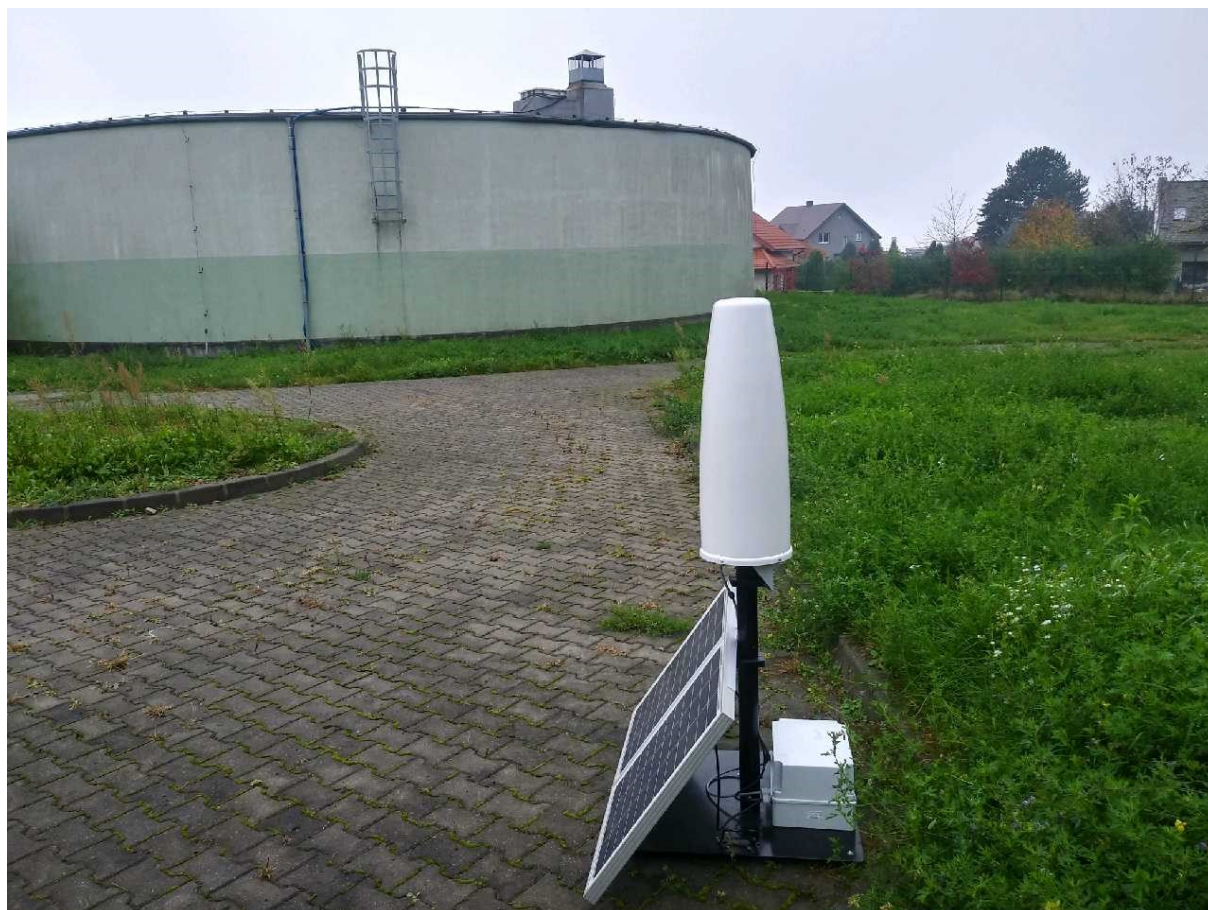
Rys. 2 Miejsce montażu SELMS PEM – Wodociąg Jaworzno
