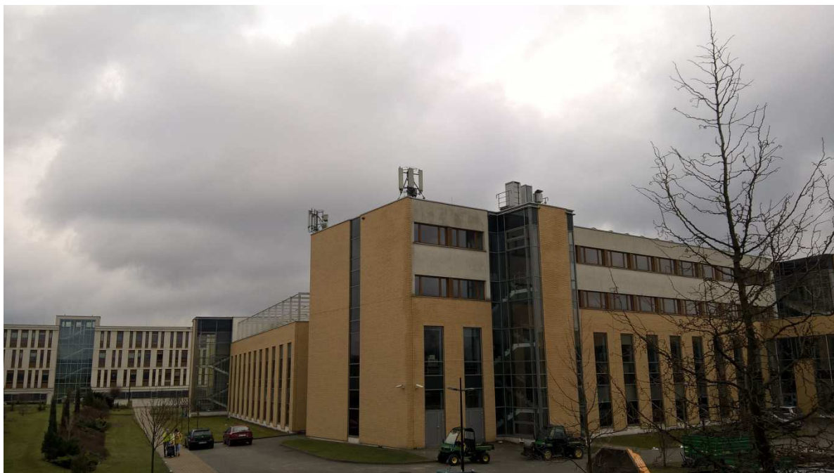
Fot. 1: Widok anten stacji bazowej ID stacji: 8516 KAMPUS UJ 2 (28251_KKR_KRAKOW_KAMPUSUJII) zlokalizowanej na dachu budynku kampusu uniwersyteckiego w Krakowie przy ul. Łojasiewicza 6
