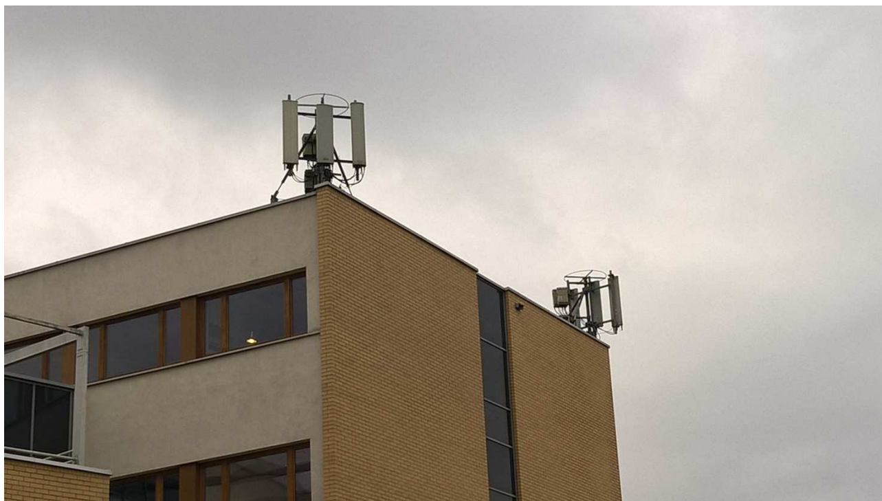
Fot. 3: Widok anten stacji bazowej ID stacji: 8516 KAMPUS UJ 2 (28251_KKR_KRAKOW_KAMPUSUJII) zlokalizowanej na dachu budynku kampusu uniwersyteckiego w Krakowie przy ul. Łojasiewicza 6
