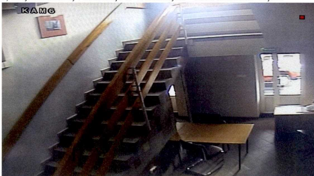
6) Budynek Komendy Powiatowej PSP w Krotoszynie – klatka schodowa i wejście
