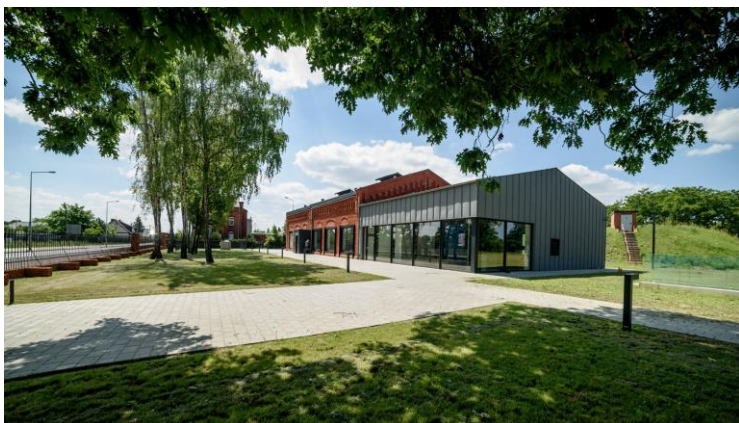
Rys. 4. Stacja Uzdatniania Wody w Zaborowie (wodociąg publiczny Leszno – raportowany do Komisji Europejskiej)
