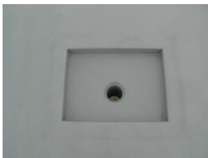
A. Otwór w ustroju nośnym mostu przed wbudowaniem wpustu
