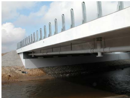
Rys. 8.17. Instalacja odprowadzająca wodę z wpustów
