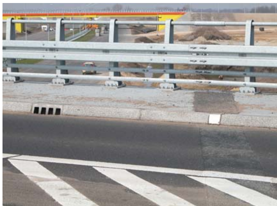
Rys. 8.4. Prawidłowo wykonana nawierzchnia przy krawężniku
