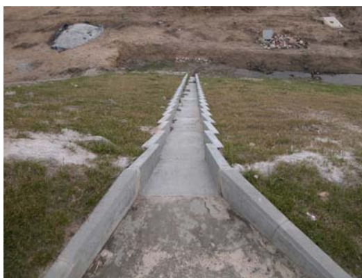
Rys. 8.20. Ściek skarpowy wykonany prawidłowo poza przyczółkiem
