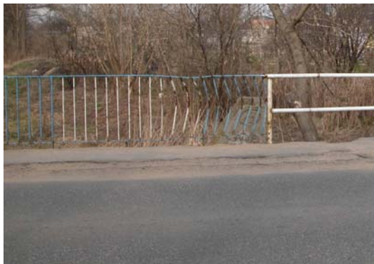
Rys. 8.14. Ściek przykrawężnikowy wypełniony piaskiem
