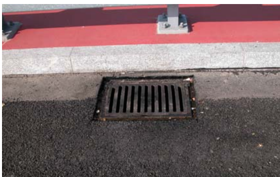
Rys. 8.5. Prawidłowo osadzony wpust mostowy
