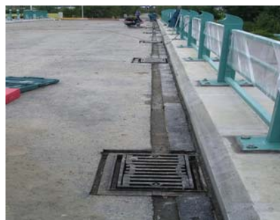
D. Wpust mostowy po wbudowaniu
