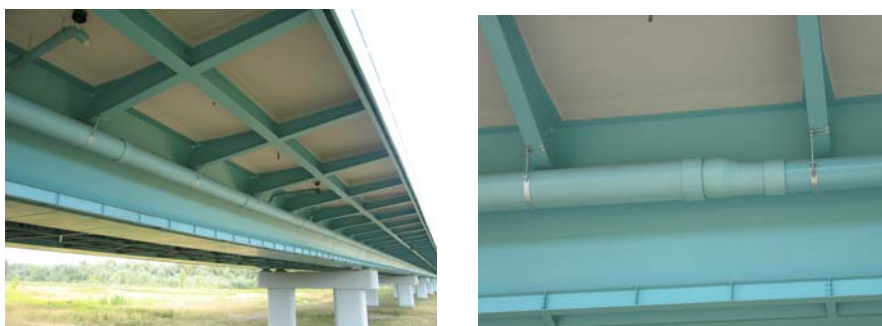
Rys. 3.4. Instalacje odprowadzające wykonane z duroplastów
