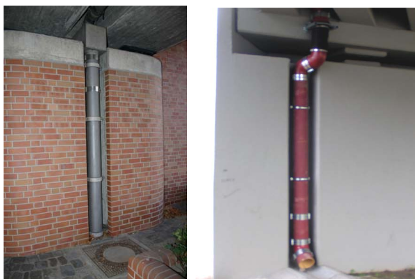
Rys. 6.11. Rura spustowa prowadzona we wnęce oraz studnia kontrolna kanalizacji deszczowej
