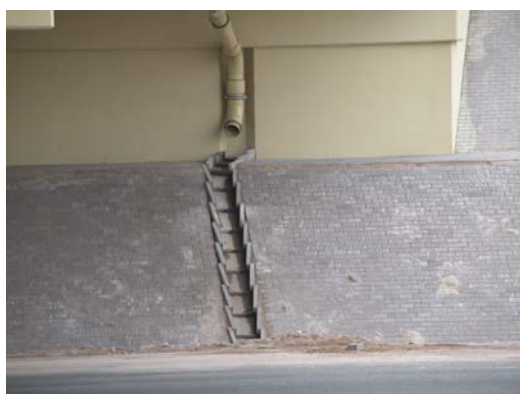
Rys. 8.19. Wyprowadzenie wody na skarpe przyczółka
