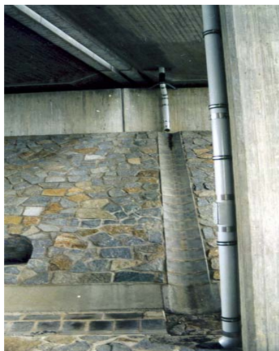
Rys. 3.5. Instalacje odprowadzające wykonane ze stali nierdzewnej
