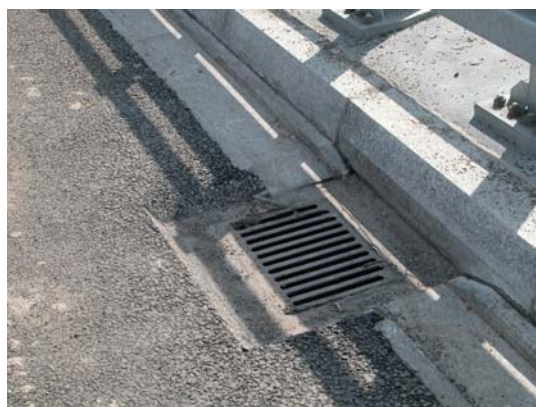
Rys. 8.13. Ściek przykrawężnikowy wykonany z płyt granitowych
