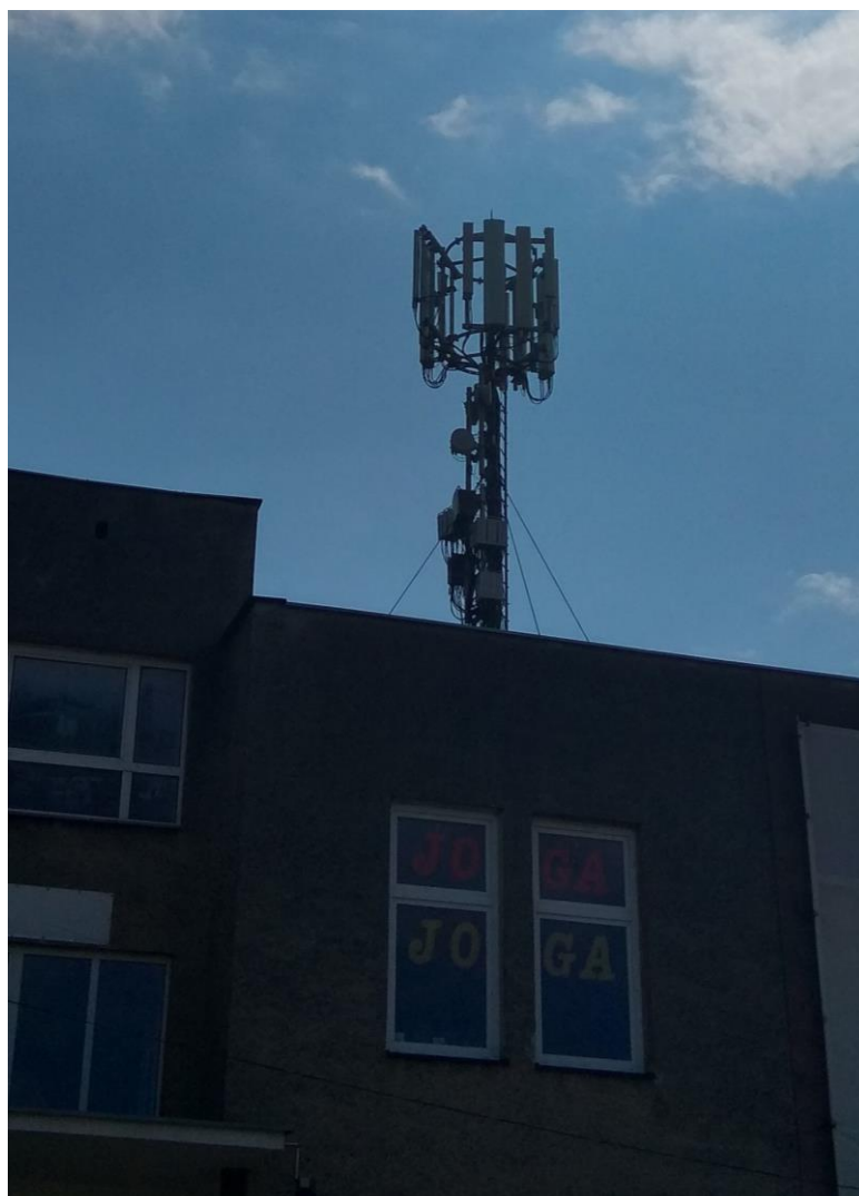
Fot. 1: Widok anten stacji bazowych: ID: OPO1030_B, ID: 53288 (37288N!), zlokalizowanych pod adresem: ul. Wrocławska 107, 45-837 Opole
