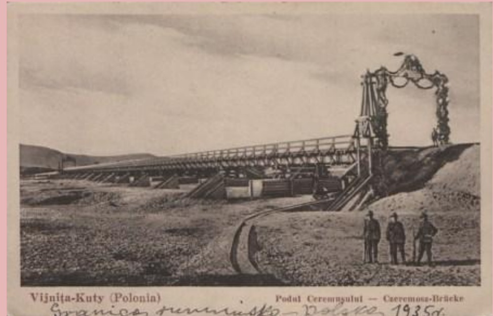
Συνοριακή γέφυρα στον ποταμό Τσερέμος στο Κούτι
