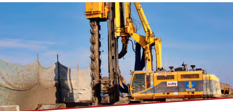
Fot. 1. Realizacja przesłony przeciwfiltracyjnej – wykorzystanie narzędzia TFoW.
