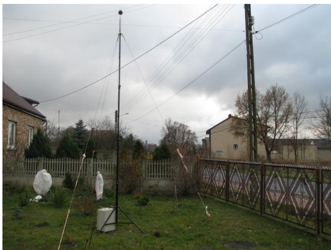
Fot. 1. Krzepice, RB1. Lokalizacja punktu pomiarowego przy ul. Kuków
