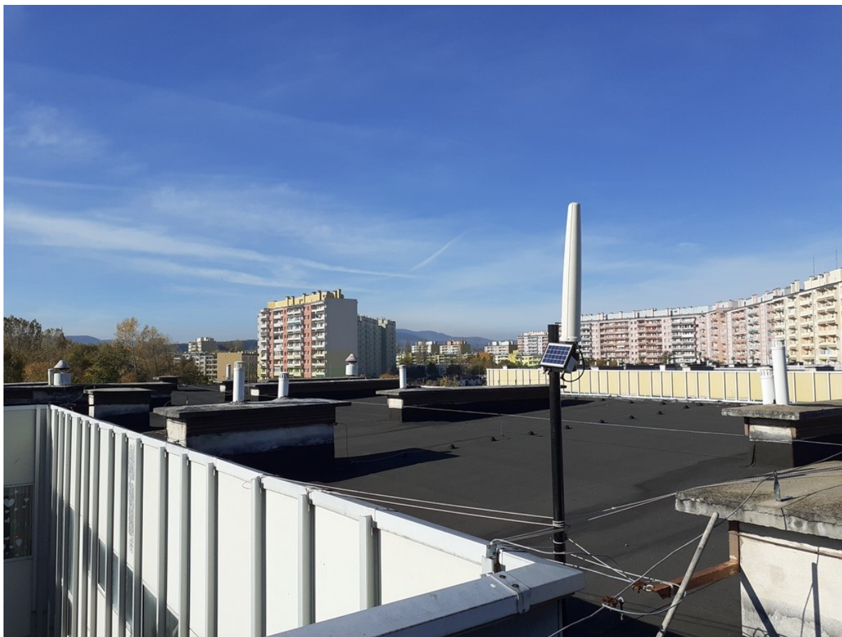
Rys. 2 Miejsce montażu SMS PEM – Szkoła Podstawowa nr 21 w Wałbrzychu
