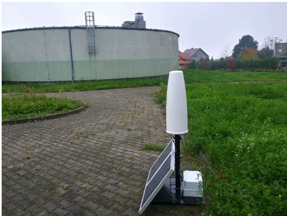
Rys. 7 Lokalizacja pomiarowa – Wodociąg Jaworzno
