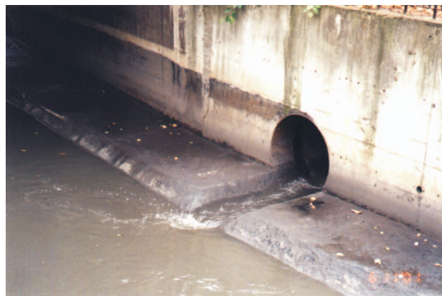
Fot. 1. Rawa w Katowicach, wylot nr 16 R, ul. Kantorówny
