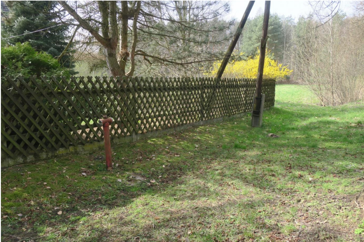
Fot. 1 – Ogrodzenie wraz z podmurówką do rozbiórki
