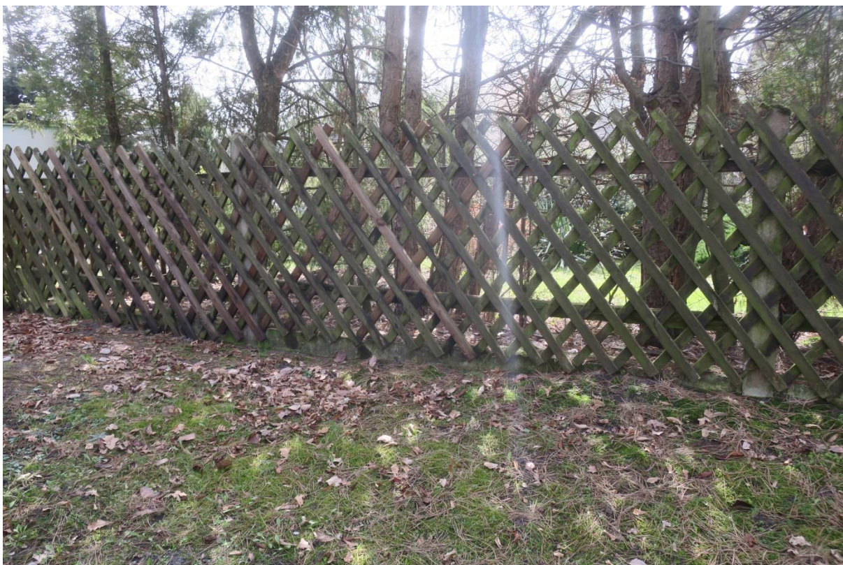
Fot. 2 – ogrodzenie do rozbiórki
