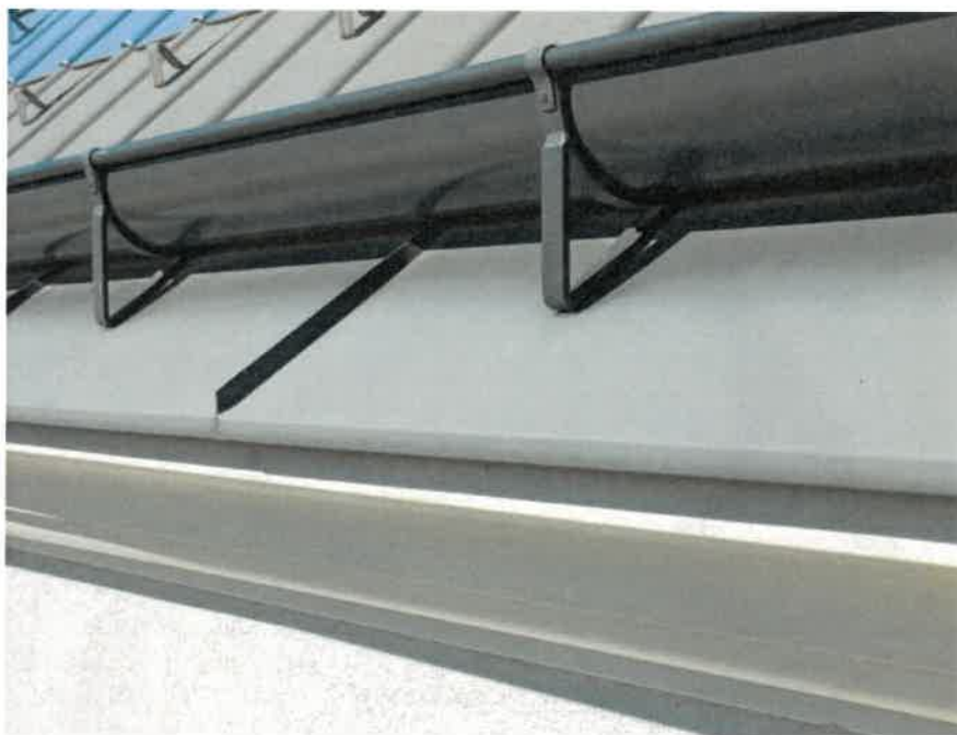
Przykład montażu rynny leżącej – z zastosowaniem uchwytyw rynnowych ze wspornikami
