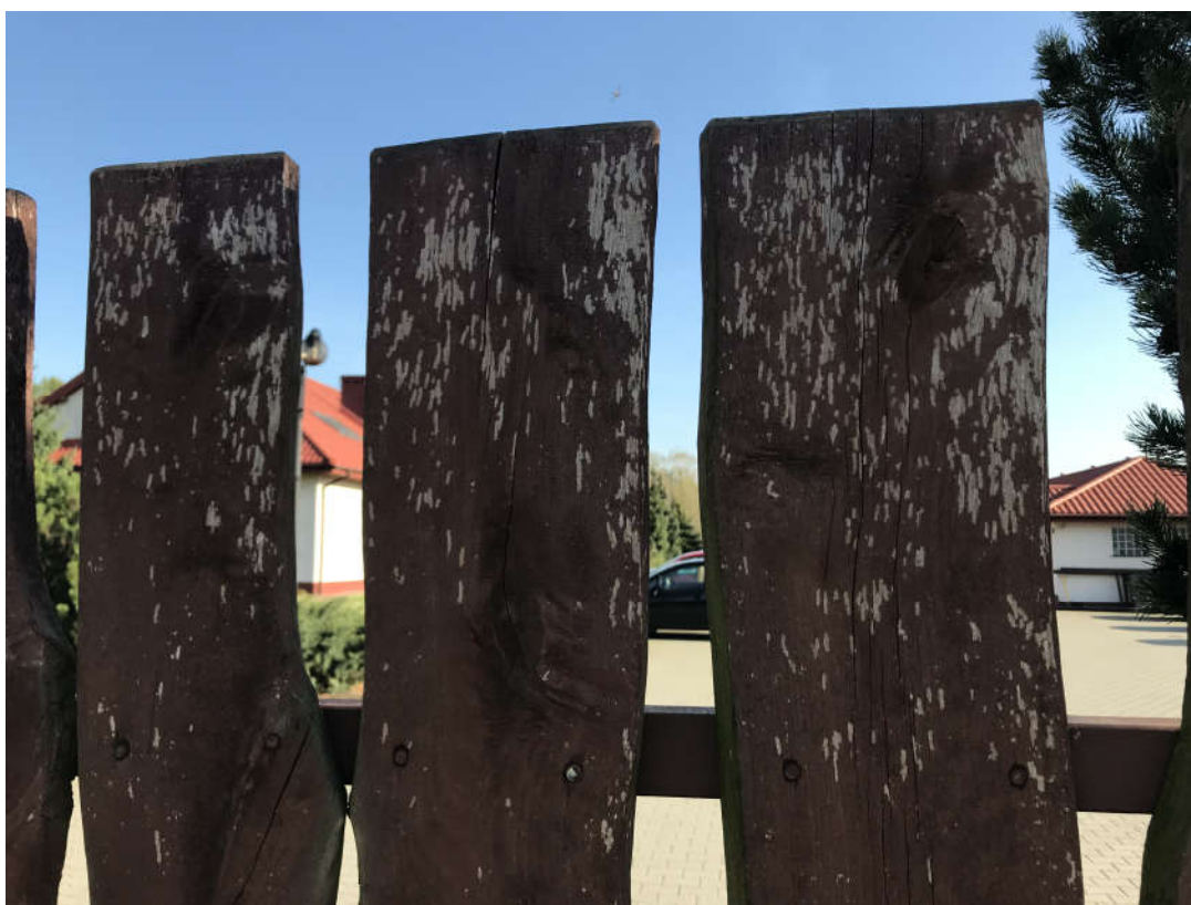
Fot. 8: Elementy drewniane ogrodzenia
