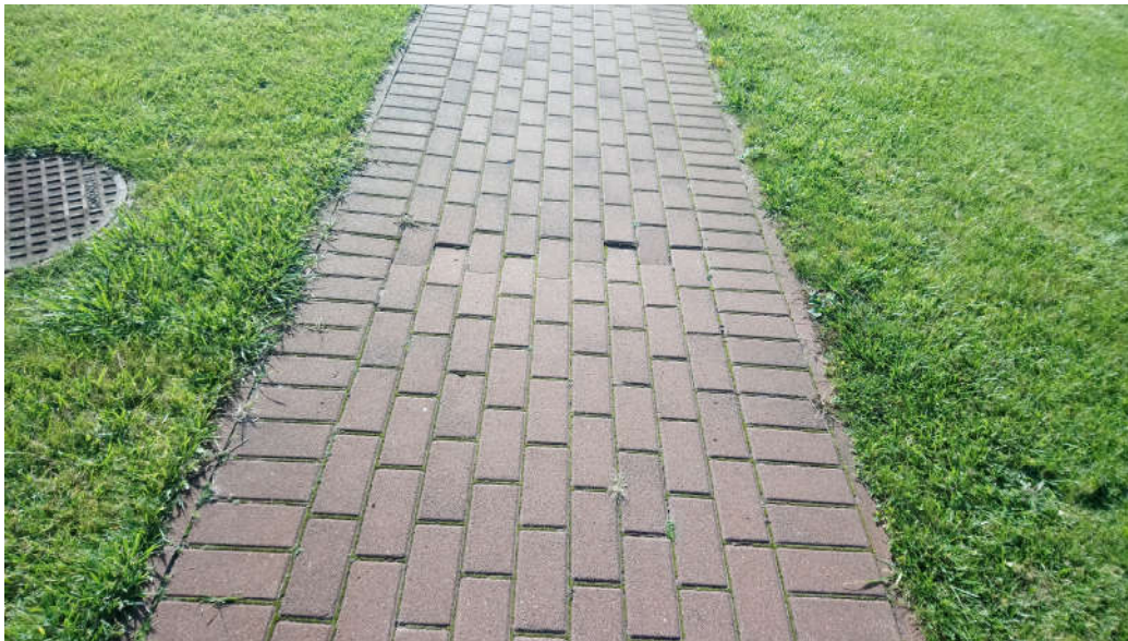
Fot. 11: Fragment dojścia do budynku
