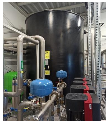
Zdjęcie 3) Zbiornik wody uzdatnionej i zestaw pompowy tłoczący wodę w instalację wodociągową
