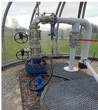
Zdjęcie 1) Otwór wiertniczy Poddebice GT-2, którym wydobywana jest woda termalna z głębokości 2101 m
