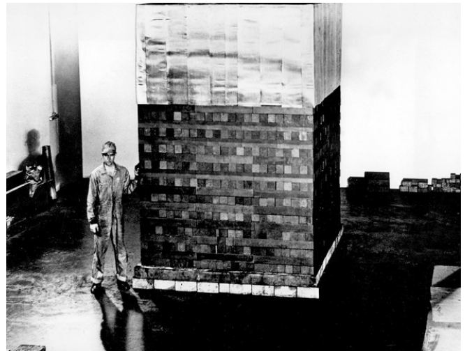
Rys. 3. CP-1 pierwszy na świecie reaktor jądrowy; źródło: United States Department of Energy .
