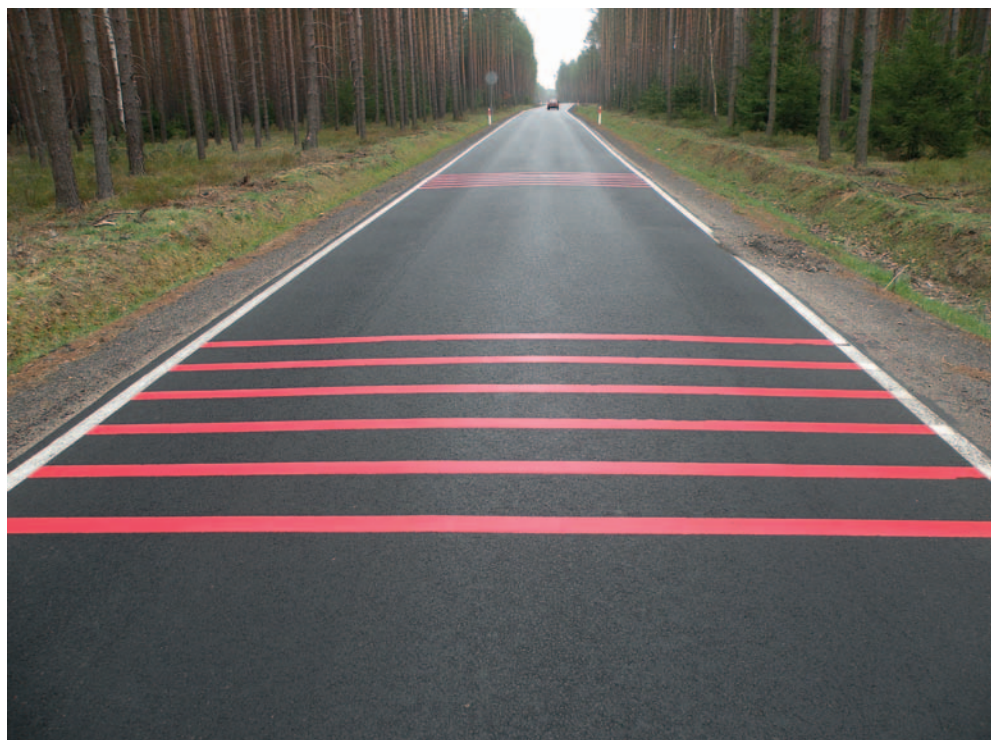
Fot. 28. Pasy akustyczno-wibracyjne na nawierzchni drogi przechodzącej przez Bory Dolnośląskie (© S. Nowak)
