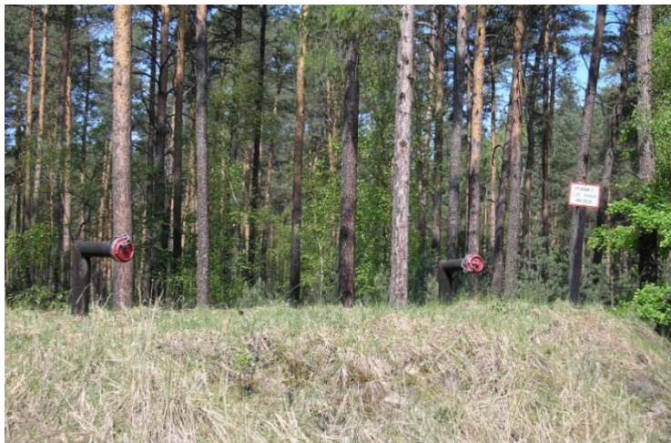
Zdjęcie 8. PODZIEMNY ZBIORNIK PUNKTU CZERPANIA WODY L-CTWO GŁOGÓWKO /FOT. W.DEMPNIAK/
