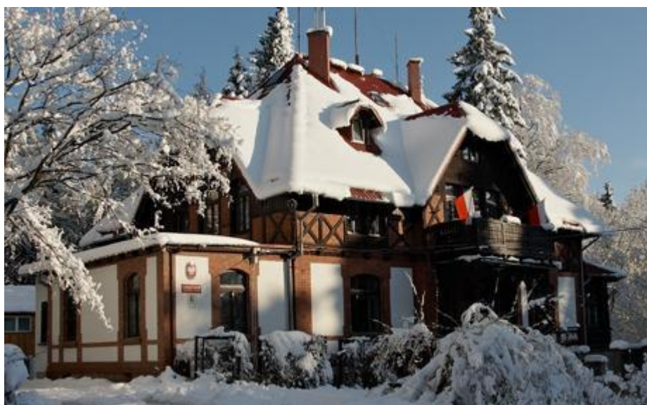
Zdjęcie 1. SIEDZIBA NADLEŚNICTWA SZKLARSKA PORĘBA (FOTO. NADLEŚNICTWO SZKLARSKA PORĘBA)
