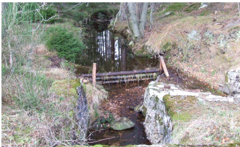
Zdjęcie 4. WYKONANE ZASTAWKI NA POTOKACH (FOTO NADLEŚNICTWO)
