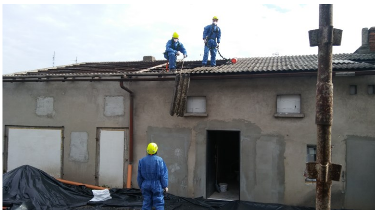
Fot. Nr 1 Pracownicy podczas demontażu.
