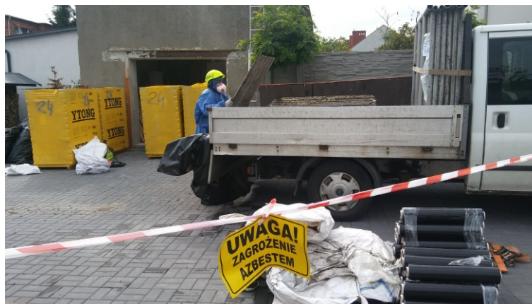
Fot. Nr 3 Płyty cementowo-azbestowe składowane na paletach, foliowane i znakowane.
