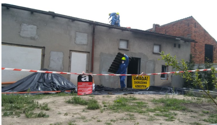
Fot. Nr 2 Zabezpieczenie terenu podczas demontażu.
