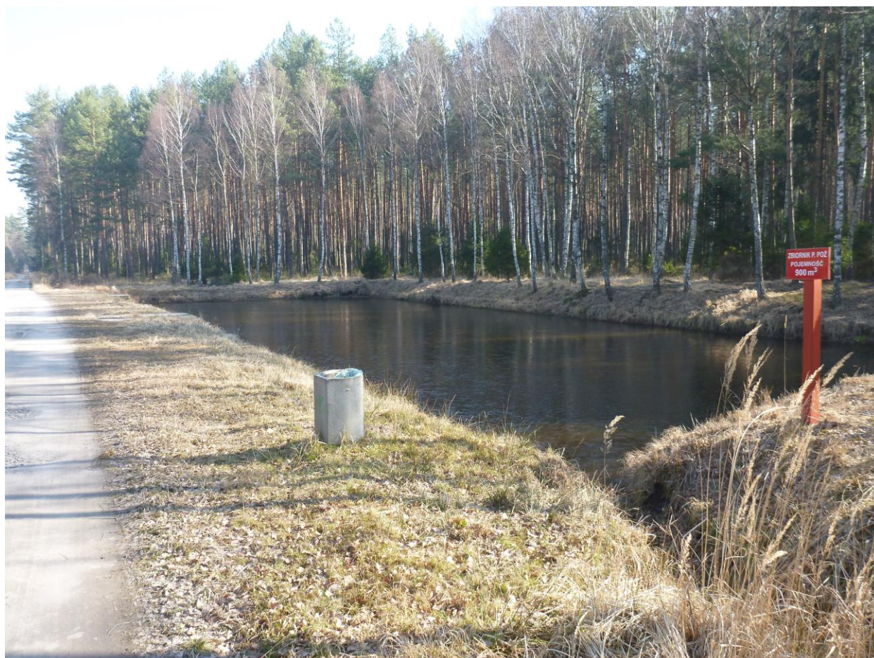
Zdjęcie 4. ŹRÓDŁA WODY DO CELÓW PPOŻ ZBIORNIK NAZIEMNY (FOTO. BULIGL)
