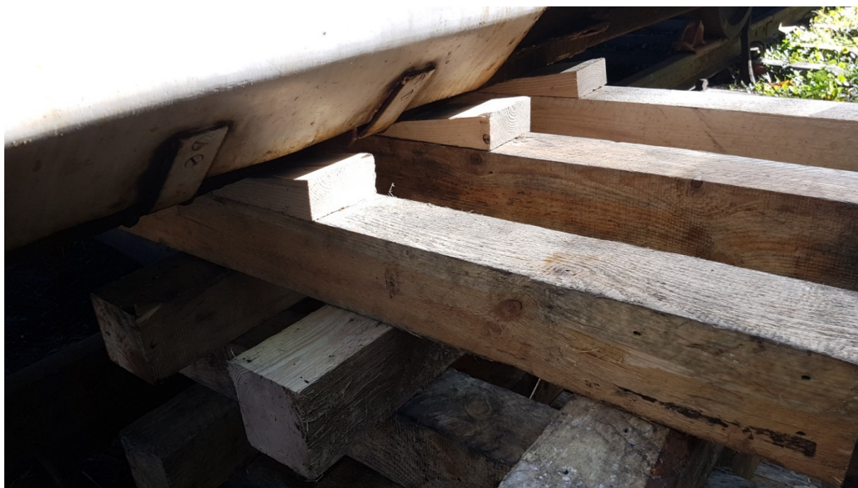
Rys. 172. Wykorzystanie klinów to podbudowy
