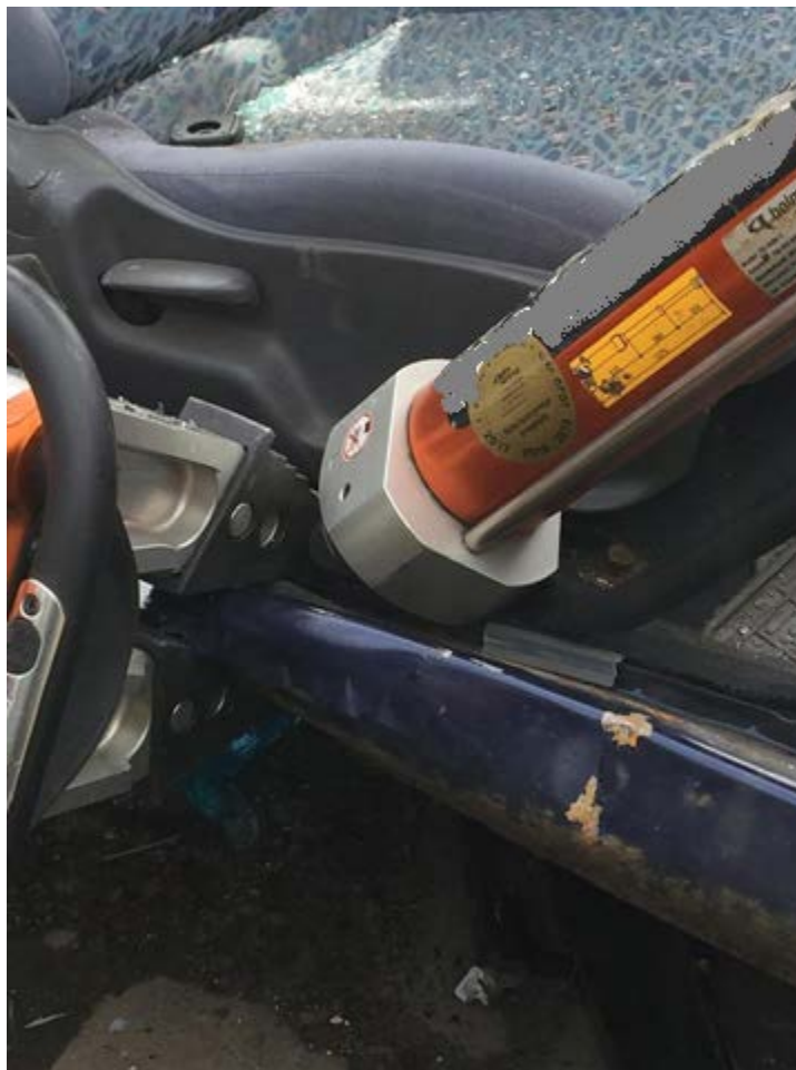
Rys. 209. Interwencyjne wyparcie cylindra rozpierającego o końcówki rozpieracza. Zabronione jest pchanie o aluminiowe ramiona
