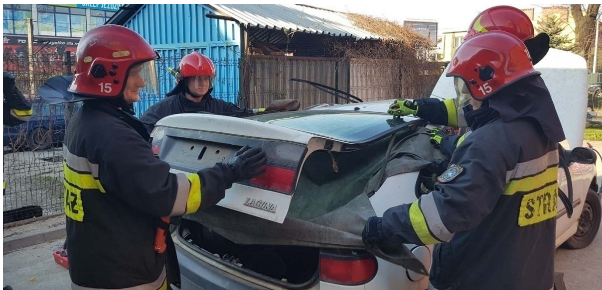
Rys. 193. Usunięcie dużej szyby kłapy aut typu hatchback z wykorzystaniem płachty
