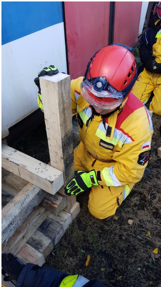
Rys. 173. Praktyczny sposób na utrzymanie osiowości stosu i odległości poza węzłami. Tu widoczna pierwsza warstwa ułożona w postaci pełnej podstawy
