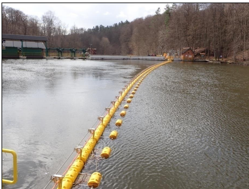
Ryc. 30. System Naprowadzania Ryb (bariera mechaniczna) znajdujący się na górnym stanowisku przy Elektrowni Kamienna na Drawie w obszarze Drawieńskiego Parku Narodowego znana jako (proponycja polskiej nazwy z wersji angielskiej Fish Guidance System - FGS)
