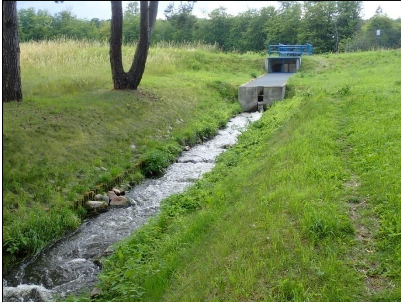
Ryc. 15. Przepławka tzw. bliska naturze jako obejście da piętrzenia w Rejowicach z widocznym fragmentem przepławki technicznej szczelinowej dla górnego wejścia
