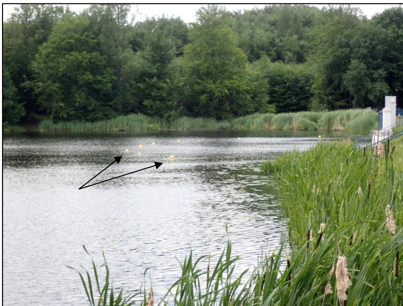
Ryc.84. Zbiornik Rejowe z widocznymi żółtymi pływakami elektrod bariery elektryczno-elektronicznej odstraszające ryby od wejścia na urządzenia piętrzącej
