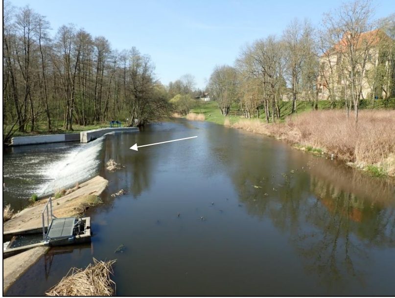
Ryc. 76. Węzeł wodny w płotach, część ryb a szczególnie schodzące smolty ryb łososiowatych mogą, bez przeszkód dla przeżycia, spławiać się przez próg pietrzący (biała strzałka)
