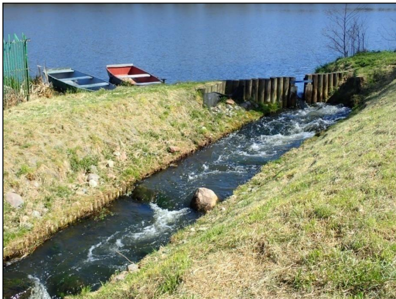
Ryc. 16. Przepławka tzw. bliska naturze jako obejście da piętrzenia w Likowie gdzie na całej długości przepławki ma charakter naturalnego potoku - wlot do przepławki na górnej wodzie
