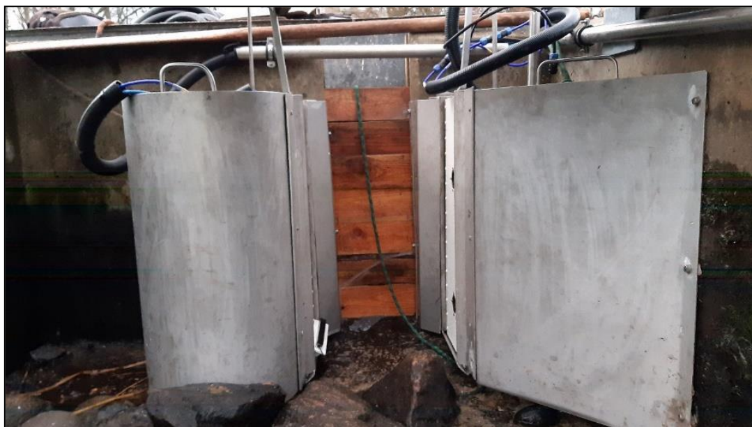
Ryc. 26. Skaner monitoringu z kamerami i przetwornikiem hydroakustycznym umieszczony jest w pierwszej górnej komórce - przepławka w Płotach, widok w czasie serwisu (udostępnione przez Escort Sp. z o. o.)
