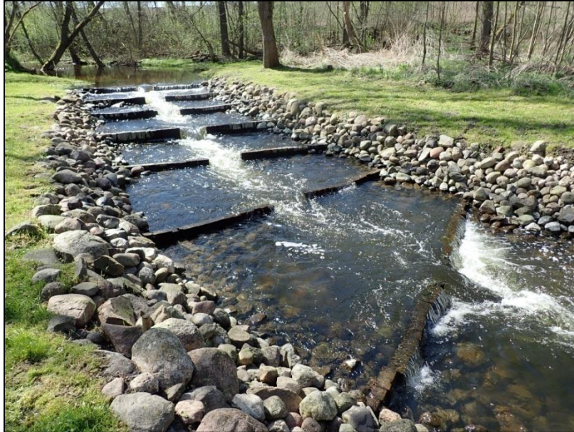
Ryc. 17. Górna część przepławki w Mieszewie na rzece Uklei w postaci poprzecznych przegród na całej szerokości strumienia tworząc miejsca spoczynkowe dla ryb o słabszych umiejętnościach pływackich
