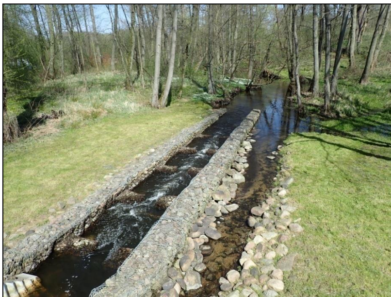
Ryc. 18. Dolna część przepławki w Mieszewie na rzece Uklei poniżej mostu wykonana z gabionów wypełnionych kamieniem w przypominające bloki skalne typowe dla szybkiego nurtu
