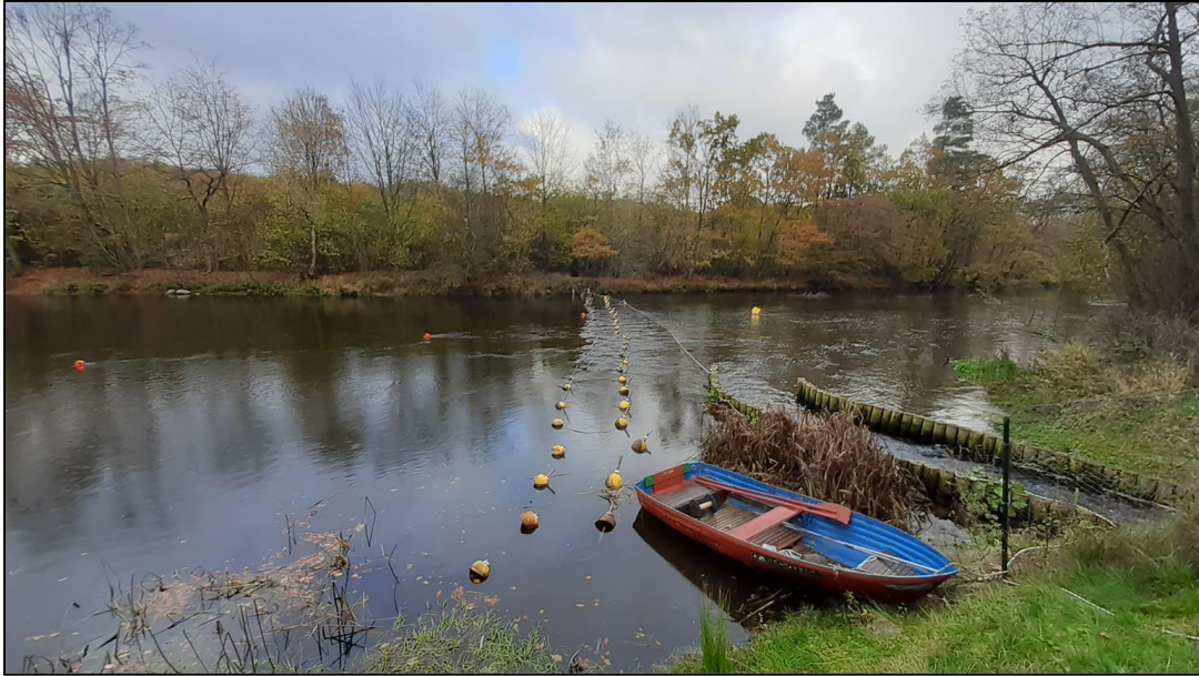
Ryc. 89. Woda dolna dla Zbiornika Rejowice – na zdjęciu bariera elektryczno-elktroniczna i wejście do przepławki przedłużone palisadą (źródło: dr inż. Sabina Ziolo)
