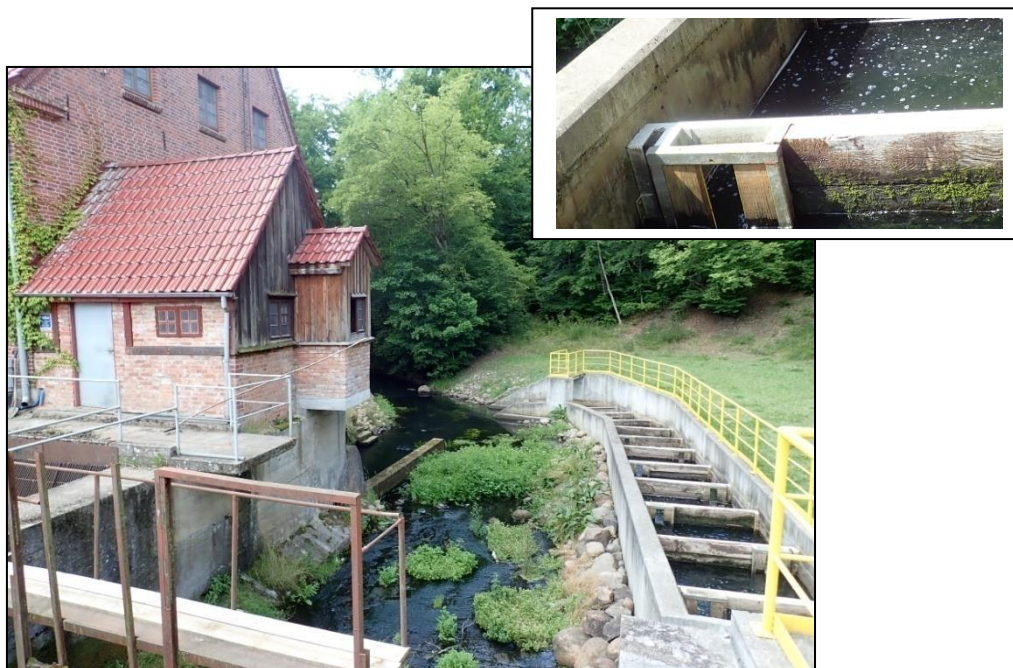
Ryc. 19. Przepławka komorowa przy MEW w Tarnowie, na szczególe pokazano element konstrukcyjny z otworem (przelewem) w ścianie działowej wykonanej z drewna
