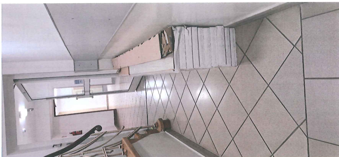
Składowanie materiałów palnych, parter klatka S3
