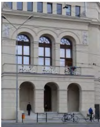
Uniwersytet Artystyczny Poznań - końcowe prace remontowe 30 listopada 2012r.: Foto W.S.G.
