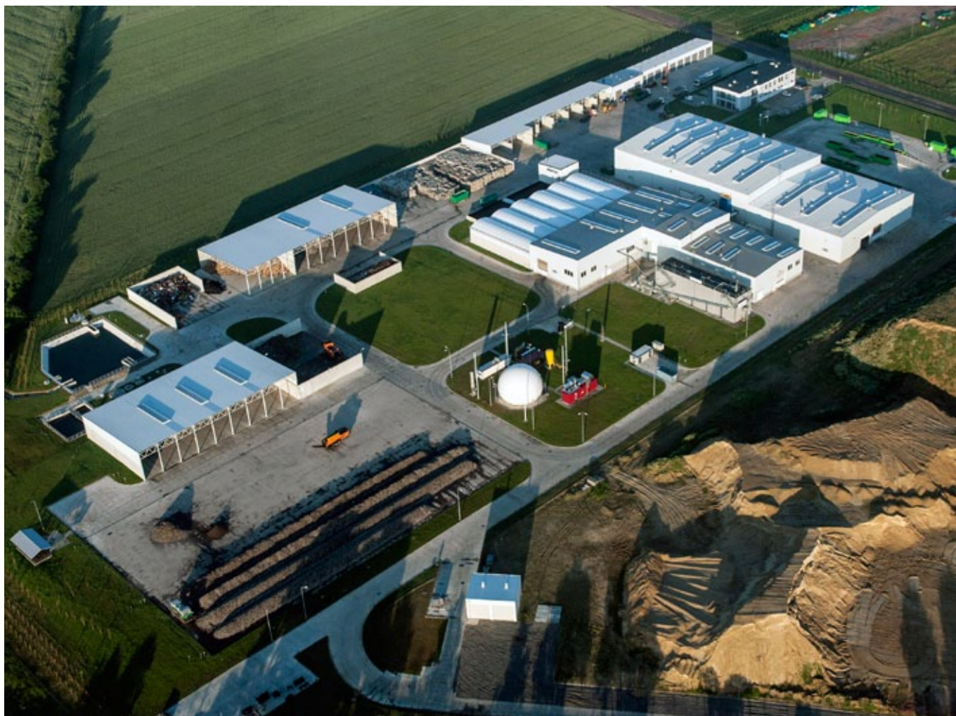
Zakład Zagospodarowania Odpadów w Jarocinie – jeden z najnowocześniejszych zakładów tego typu w Polsce. Koszt całkowity inwestycji: ponad 147 mln zł, a dotacja z POIiŚ 2007-2013: blisko 84 mln zł. Projekt zakończony w czerwcu 2016 r. Obecnie NFOŚiGW ocenia wniosek o dofinansowanie z POIiŚ 2014-2020 rozbudowy ZZO
