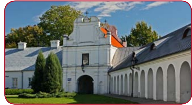
Najstarsza budowla na Górze Katedralnej – Brama Uściąguska, fot. K. Dromlewski
