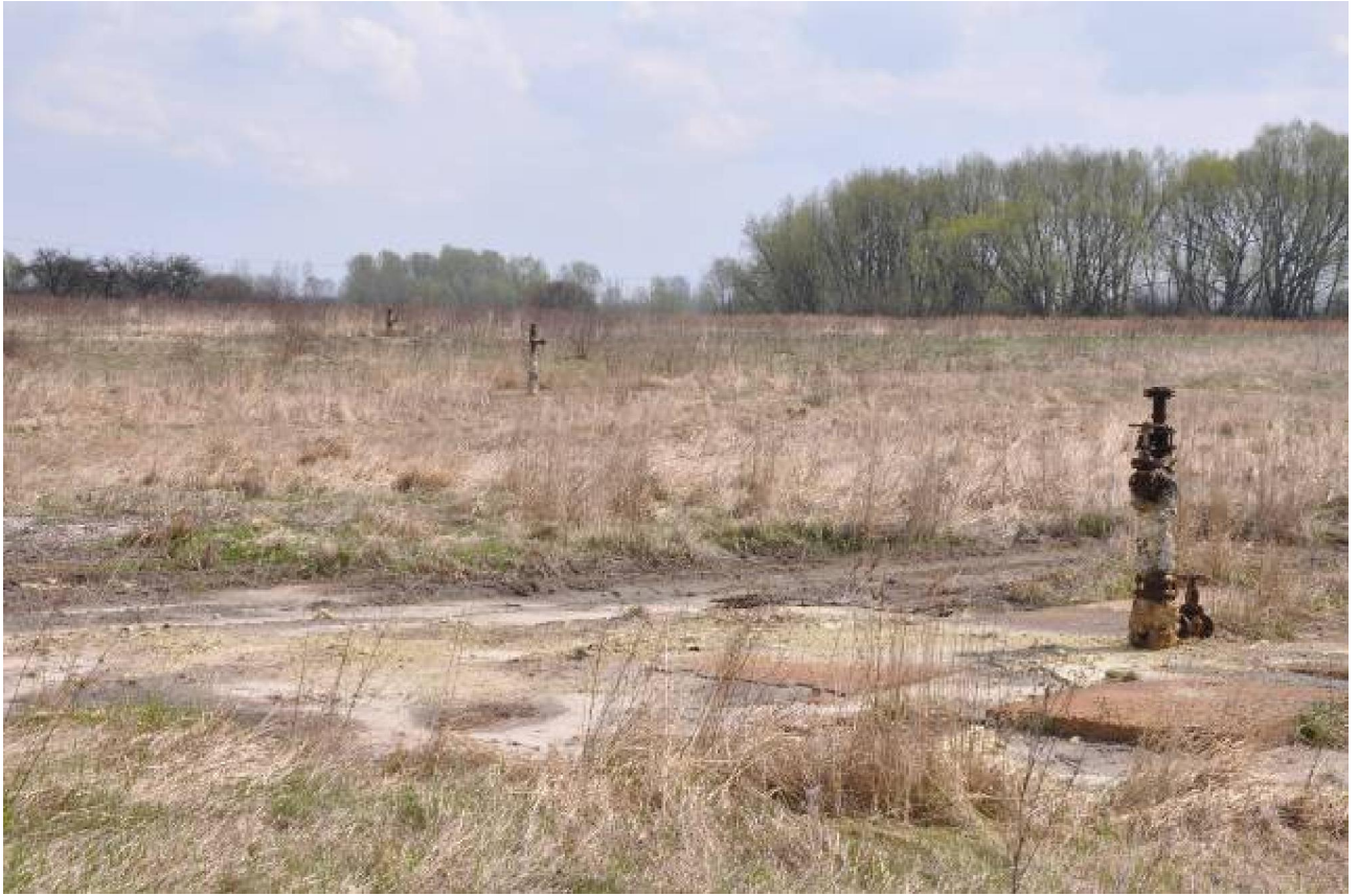
Fot. 4. Pole eksploatacyjne nieczynne. Jak widać, instalacje nie są zdemontowane do końca, teren nie jest zrekultywowany, wokół kałdego otworu pozostały duże skupiska siarki, która pozostała tam na skutek niedbałego działania eksploatacyjnego, dalej będzie się utleniać i zmieniać środowisko.
