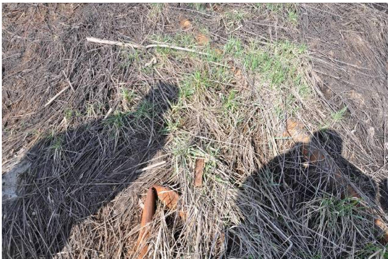
Fot. 3. „Po zakończeniu eksploatacji drogi, rurociągi i inne elementy infrastruktury s demontowane”, jak widać, nie zawsze i nie wszystkie.
